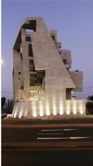
La totalidad de la edificación tiene 10 pisos con un área extensa de jardines en el nivel 06 y el techo del nivel 09. Las placas con sección en "A" se inclinan hacia el Malecón Armendáriz mientras que hacia Barranco el conjunto es escalonado para integrarse a la escala de las edificaciones en el entorno.
