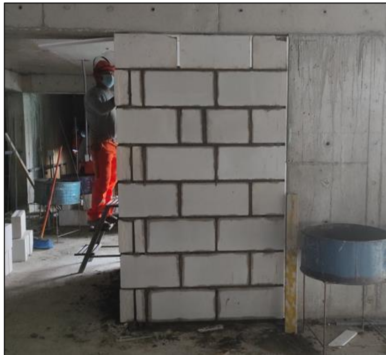
Figura 18. Tecnopor entre muro y placa estructural.
