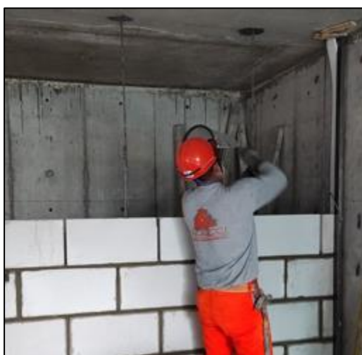
Figura 21. Muro asentado con ladrillo p-10.
