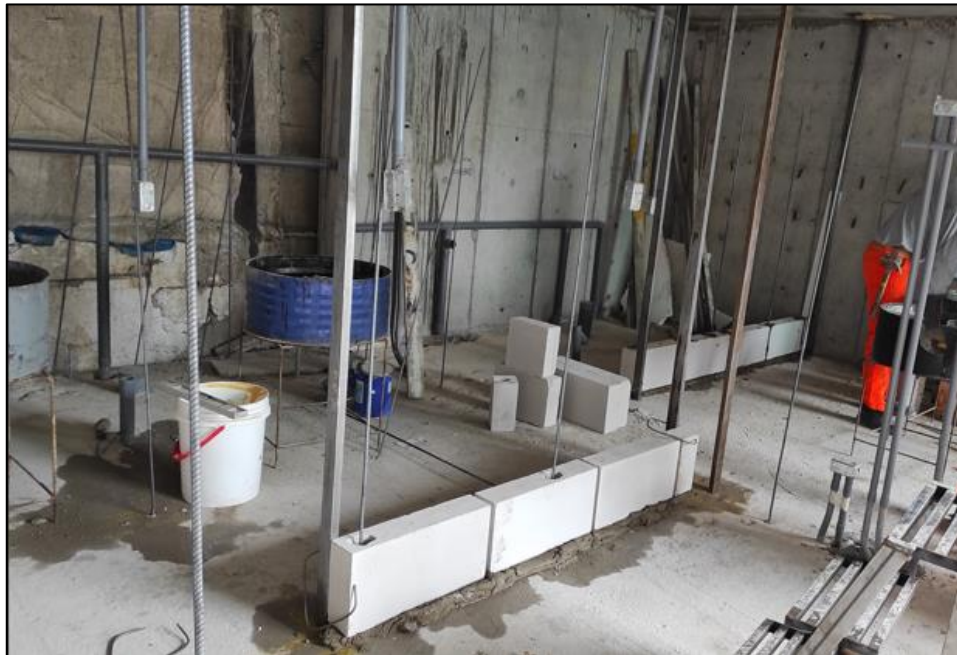
Figura 16. Primera fila asentado de muro p-10 con refuerzo vertical.
