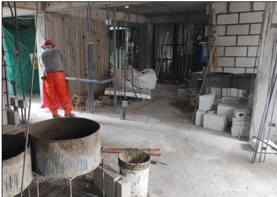
Figura 15. Anclaje de varillas.
