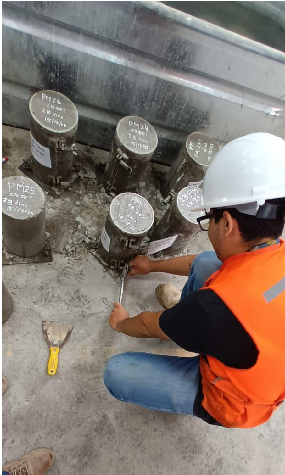
Figura 76 Desmoldado de probetas por el tesista Diego
