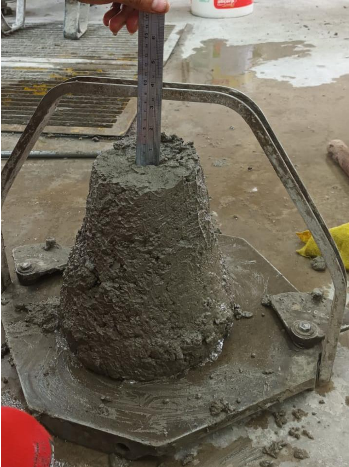
Figura 69 Asentamiento del concreto base
