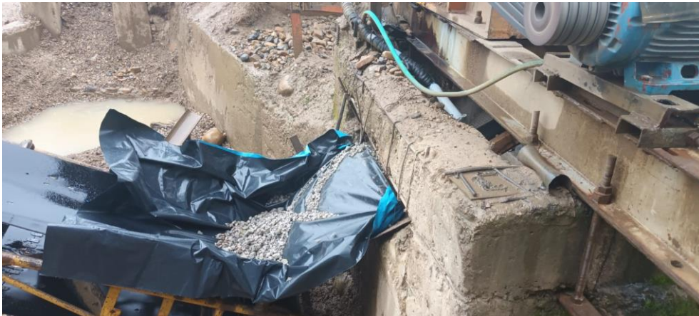
Figura 46 Recolección de agregado de concreto triturado como agregado grueso
