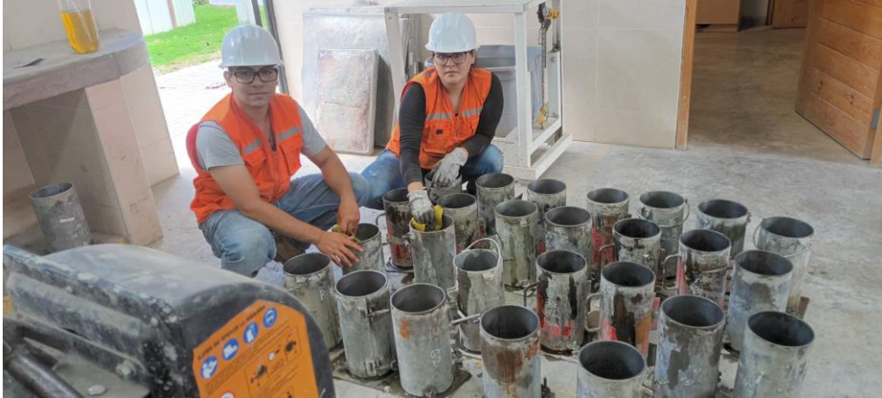
Figura 62 Engrasado de probetas para su vaciado de concreto por los testistas
