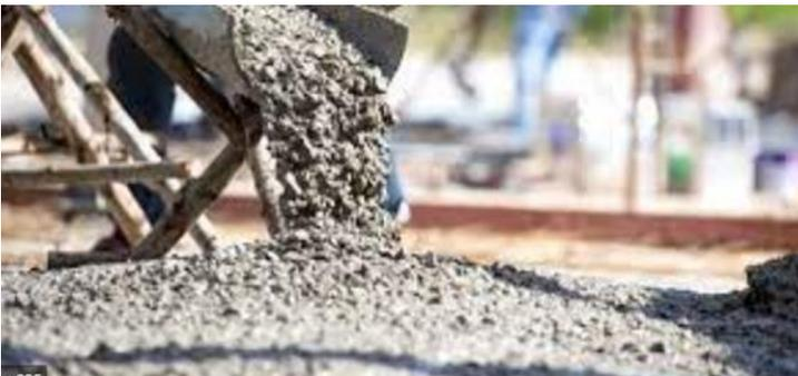
*Nota:* Se puede visualizar en la imagen la mezcla de concreto en su estado fresco.
