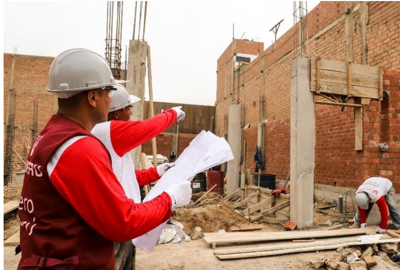
Figura 4: Construcción de vivienda con sistema aporricado en Chancay.
