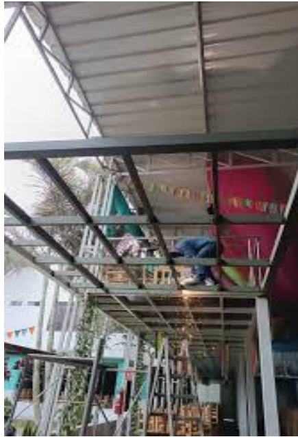
Figura 2: Fabricación de estructura metálica para polideportivo en Cajamarca.
