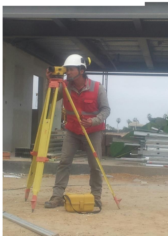
Figura 7: Verificación de las cotas con el nivel de ingeniero
