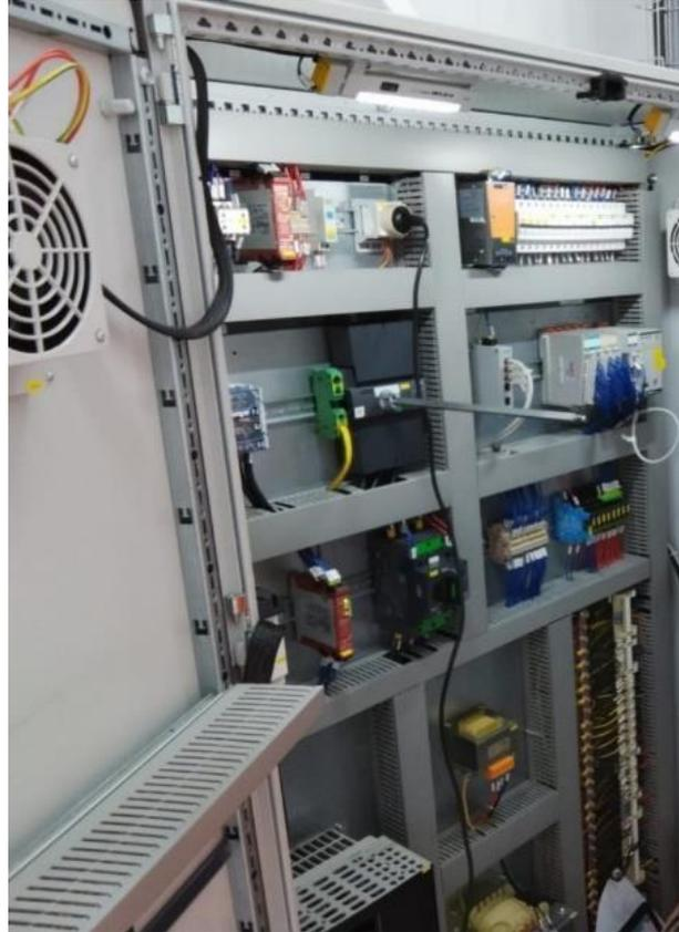
*Nota.* Tablero eléctrico de automatización para UMA (Unidad Manejadora de Aire).
