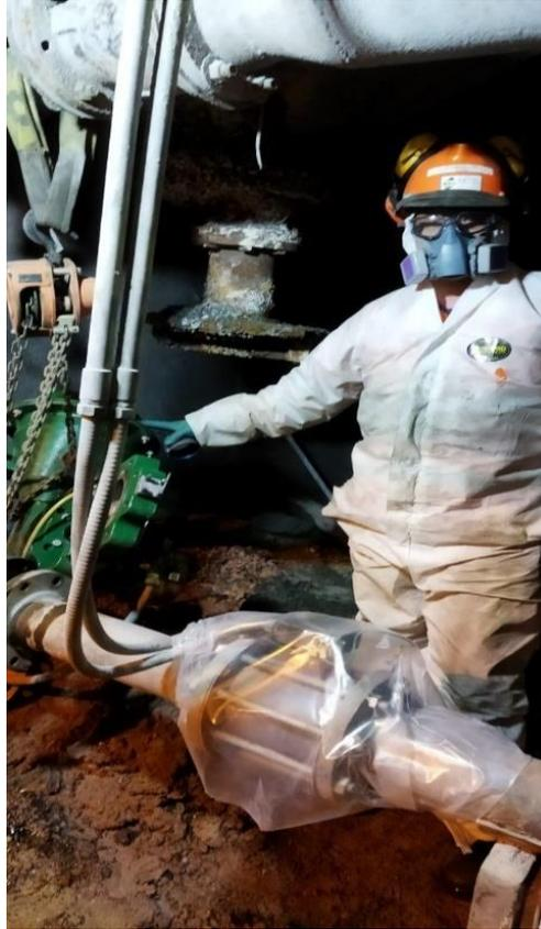
*Nota.* En la figura 6, se puede apreciar una válvula en la marca FISHER, donde se realiza las pruebas de corriente y apertura de la mariposa. Fuente: RTS Automation SAC en Servicio en Southern Copper Corporation.
