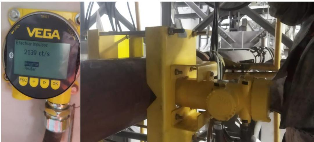
*Nota.* En la figura 7, se puede apreciar un instrumento de medición (Densímetro Nuclear). Estos equipos funcionan con un detector de centelleo que convierte los rayos gamma en pulsos de luz, a su vez la parte electrónica convierte los pulsos de luz en pulsos eléctricos en una unidad de medición llamada cuentas la cual es inversamente proporcional a densidad del material que pasa por la tubería. Fuente: RTS Automation SAC en servicio de SOCIEDAD MINERA CERRO VERDE.
