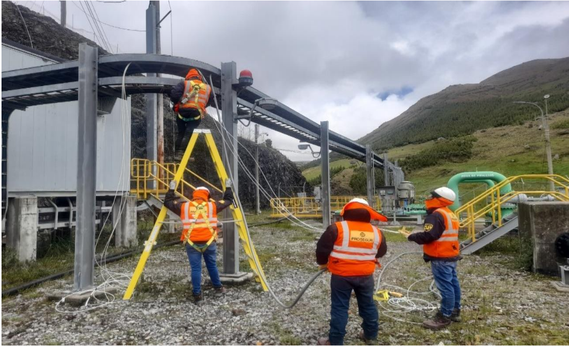
Fotografía 10. Tendido en todo el tramo de la bandeja metálica
