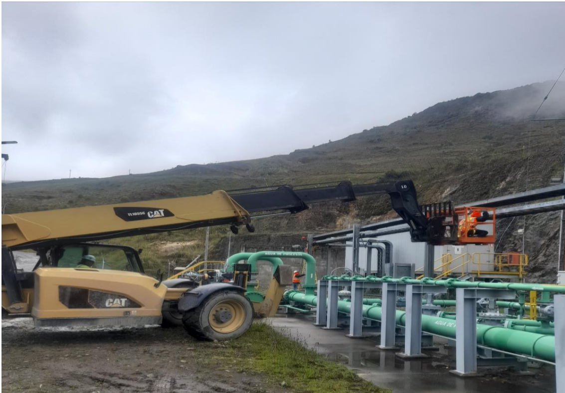
Fotografía 6. Tendido del cableado UTP sobre la bandeja existente del área Sub estación
