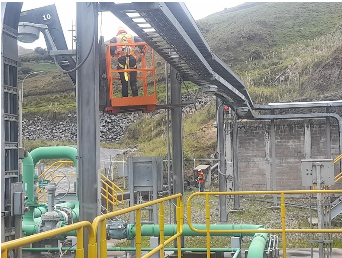
Fotografía 10. Tendido en todo el tramo de la bandeja metálica
