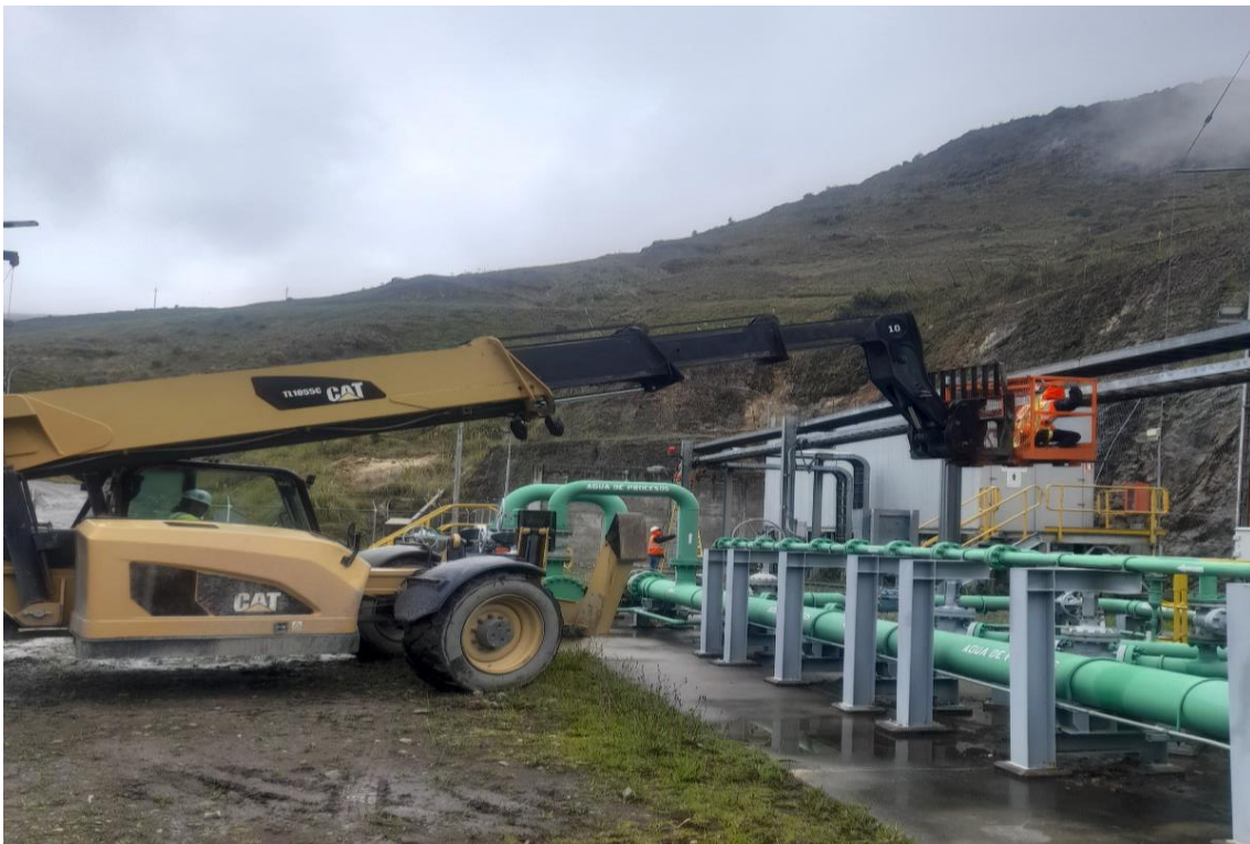
Fotografía 4. Tendido del cableado UTP sobre la bandeja existente del área Sub estación
