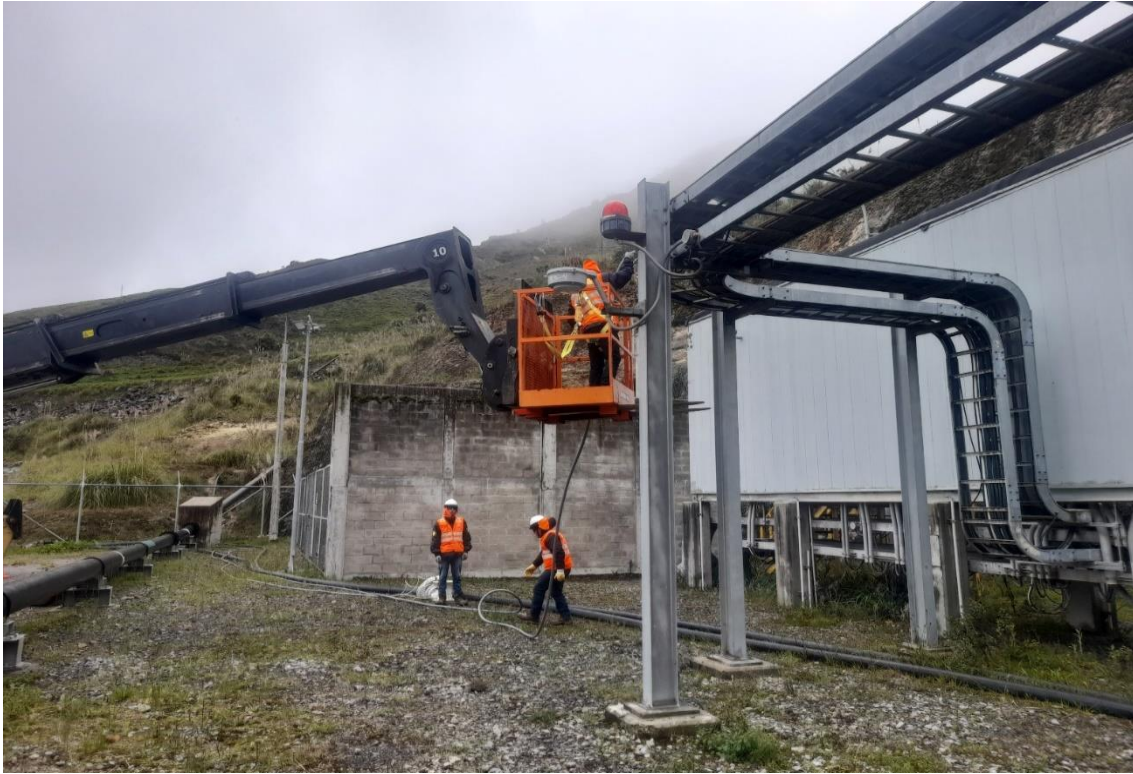
Fotografía 3. Verificación, limpieza del recorrido para el tendido de cable UTP
