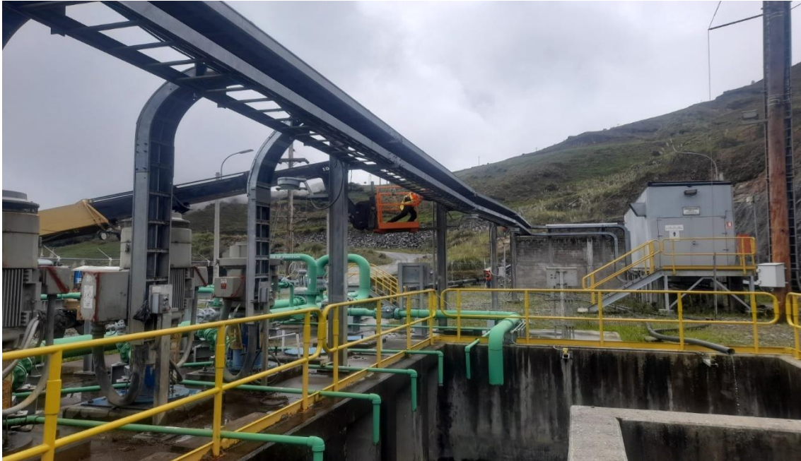
Fotografía 8. Tendido del cableado UTP sobre la bandeja existente del área Sub estación
