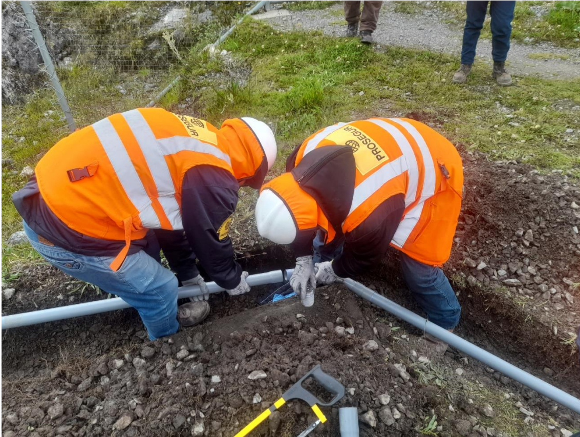
Fotografía 15. Excavación para tendido de cableado
