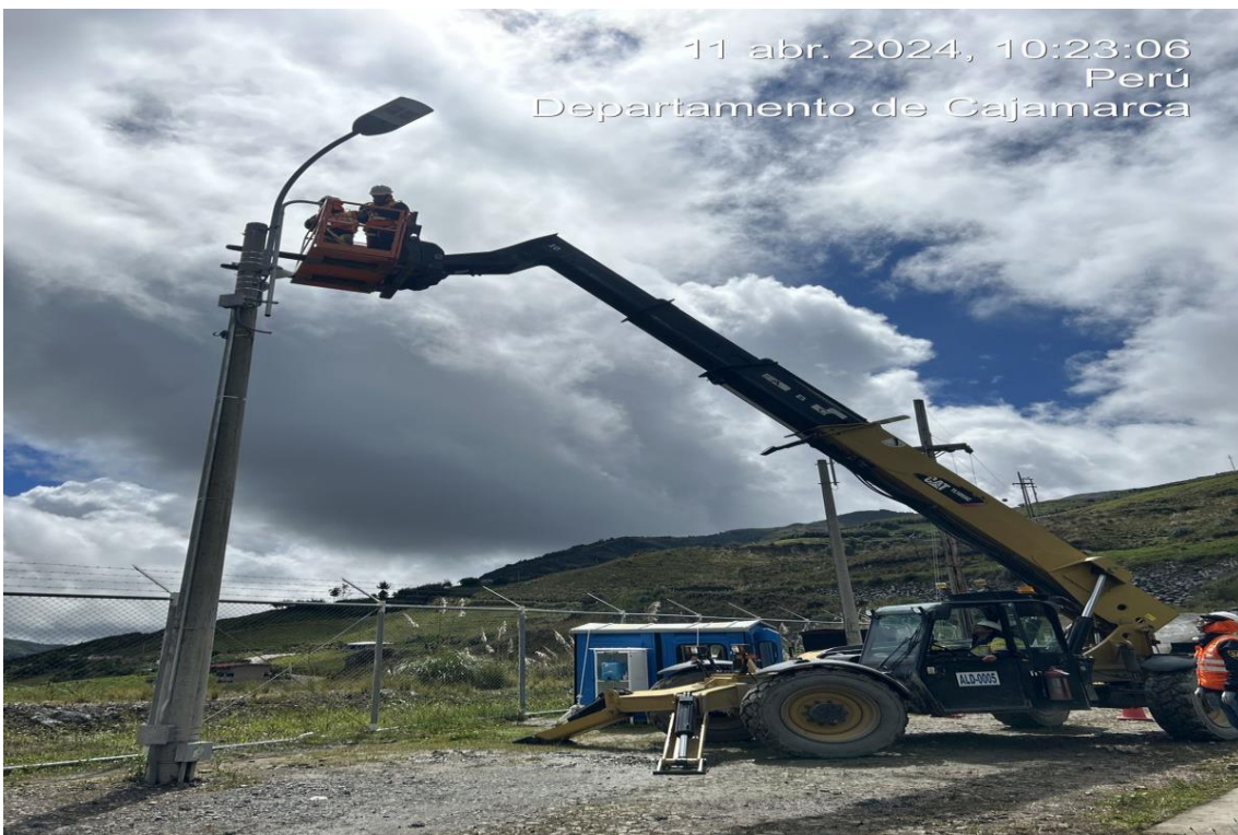
Fotografía 16. Instalación de cámara domo megáfono y strobo
