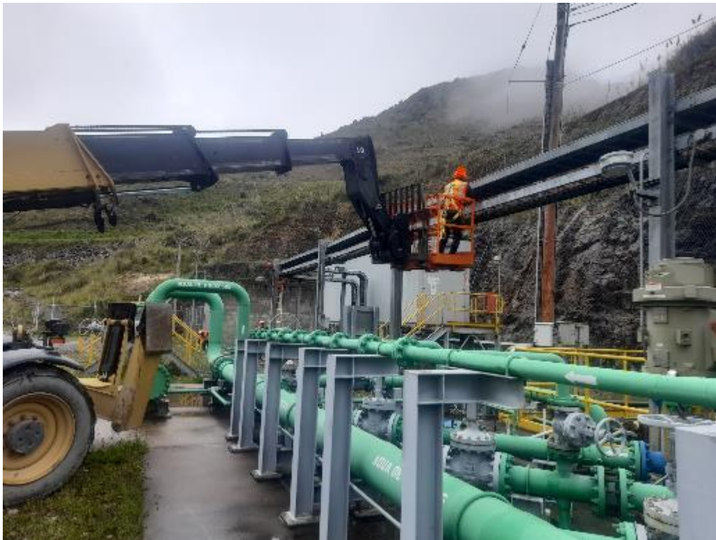
Instalación de cámara PTZ
