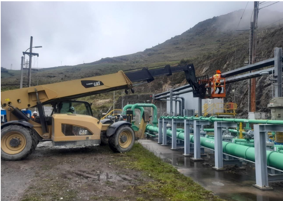
Fotografía 8. Tendido del cableado UTP sobre la bandeja existente del área Sub estación
