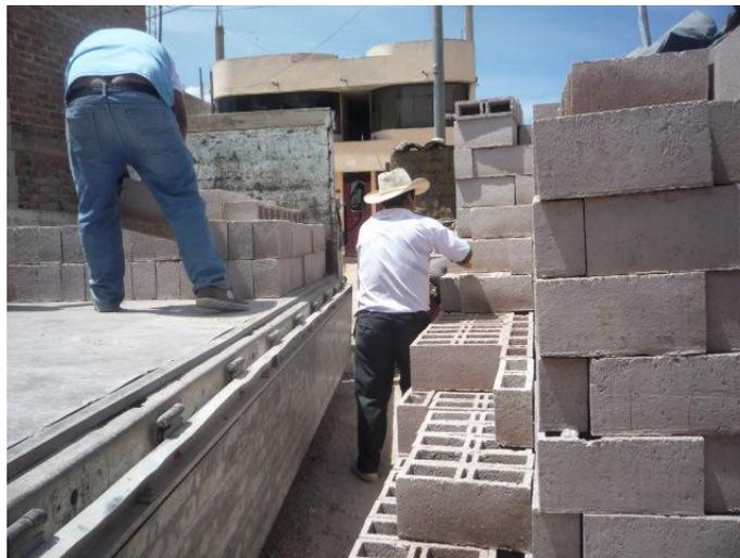
Foto N° 02: Acarreo de bloques de concreto a piso.
