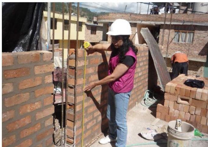
Foto N° 40: Medición de altura de muro.
