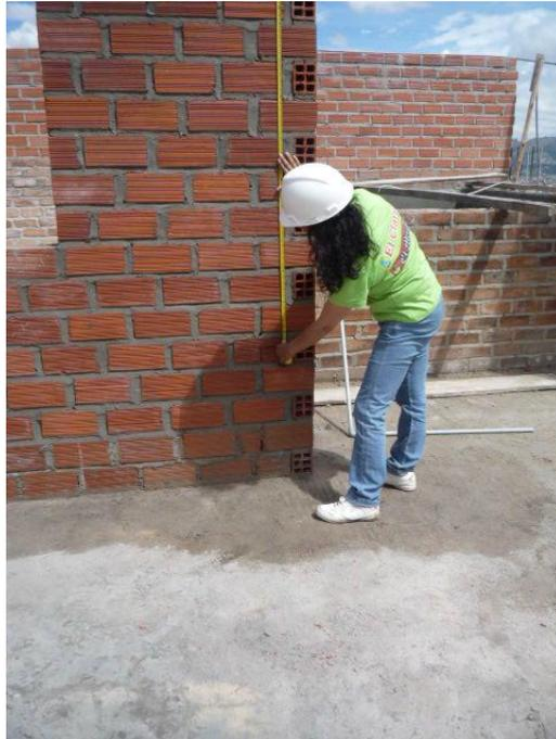
Foto N° 49: Medición de altura de muro.
