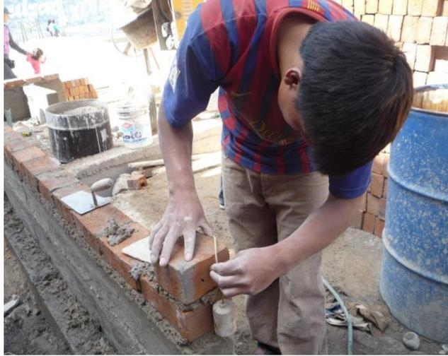
Foto N° 21: Verticalidad del muro con plomada.
