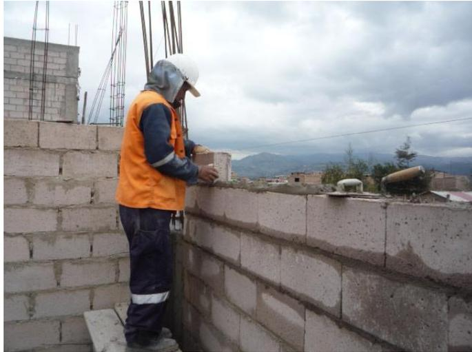
Foto N° 31: Asentado de bloques de concreto en
