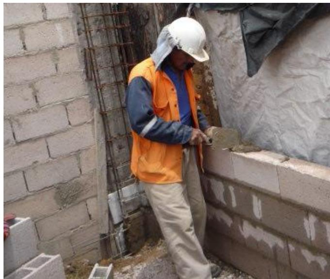
Foto N° 28: Asentado de bloques de concreto en aparejo de soga, primer nivel.
