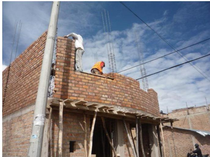
Foto N° 36: Asentado de ladrillo en aparejo de soga en altura, segundo nivel.
