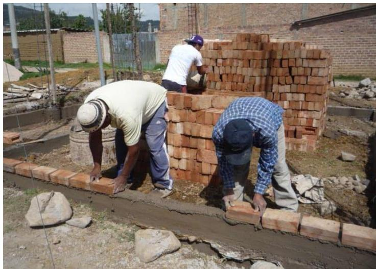
Foto N° 22: Asentado de ladrillo en aparejo de soga primera hilada.
