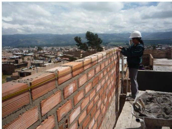
Foto N° 48: Medición de largo de muro.
