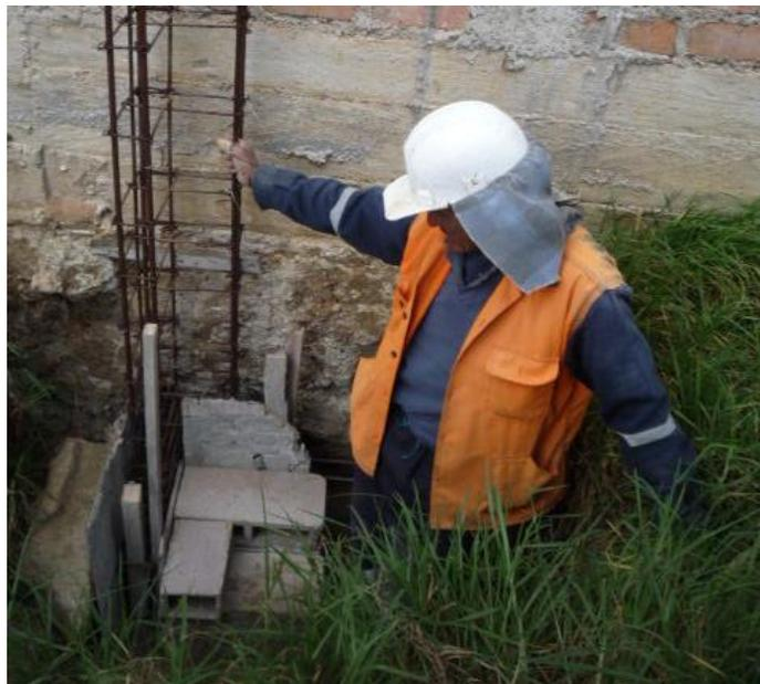
Foto N° 24: Colocación de ladrillos maestros en asentado de bloques de concreto.
