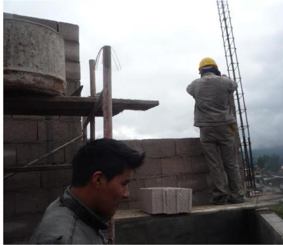
Foto N° 37: Asentado de bloques de concreto en aparejo de soga en alturas segundo nivel.
