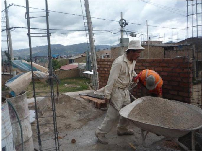
Foto N° 17: Transporte de mezcla en segundo nivel
