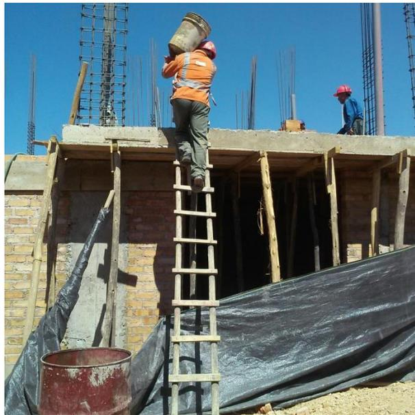
Foto N° 10: Acarreo de Agregado fino a primer techo.
