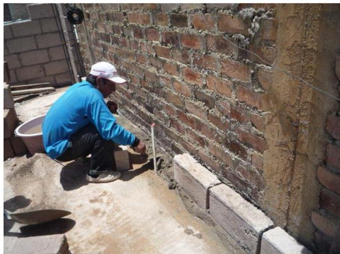
Foto N° 26: Asentado de bloques de concreto en
