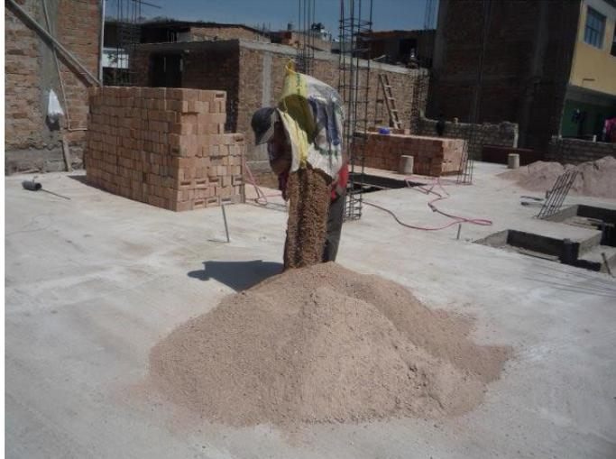
Foto N° 11: Acarreo de Agregado fino a segundo techo.
