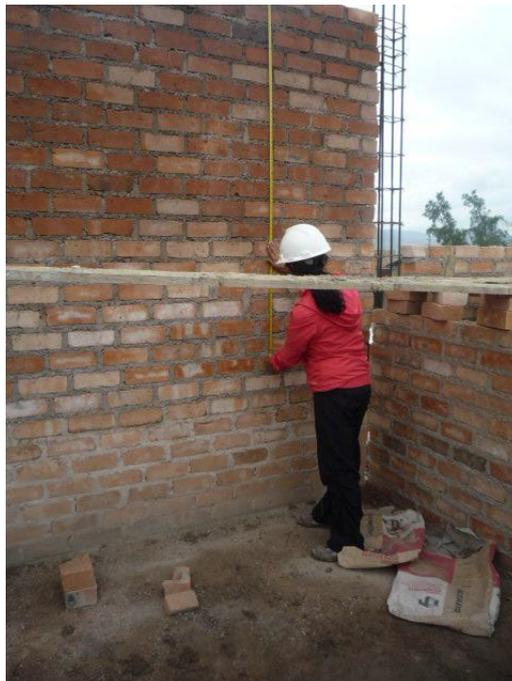
Foto N° 44: Medición de altura de muro.
