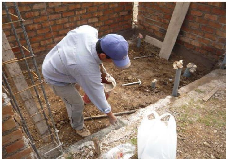
Foto N° 18: Preparando sobrecimiento para asentar primera hilada de muro.
