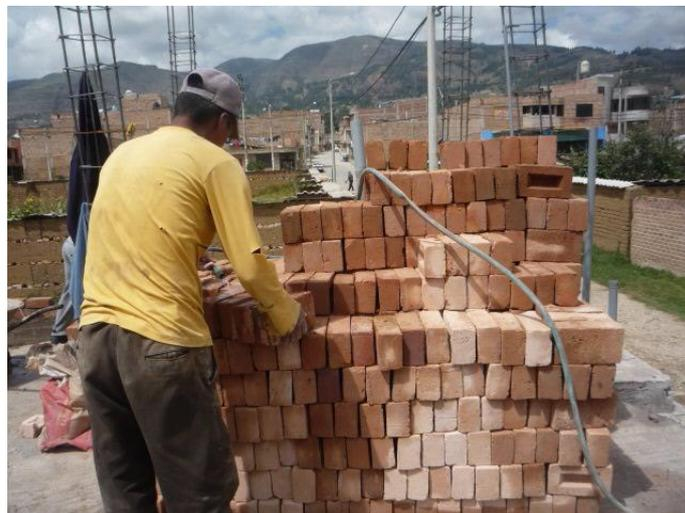
Foto N° 06: Acarreo de ladrillo de arcilla en segundo nivel.
