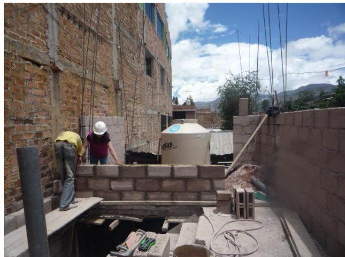
Foto N° 34: Asentado de bloques de concreto en
