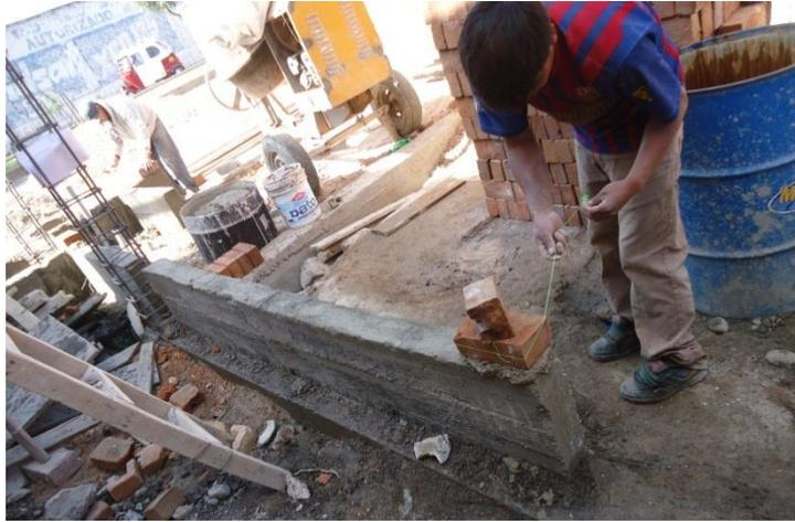
Foto N° 19: Colocación de ladrillos maestros en asentado
