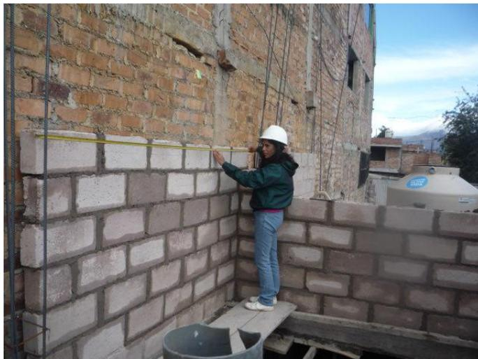
Foto N° 52: Medición de largo de muro.
