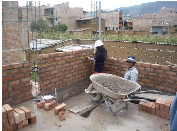
Foto N° 46: Medición de largo de muro.
