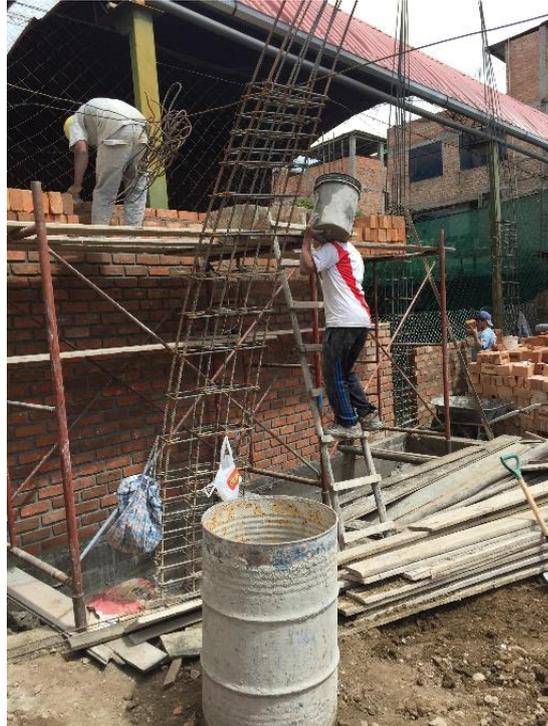
Se observa el traslado del mortero, el inadecuado almacenamiento de encofrado y el mal apoyo de la escalera
