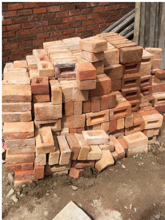
Se observa el inadecuado almacenamiento de ladrillos en obra
