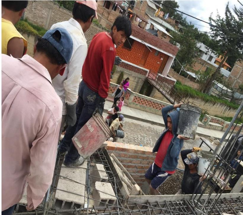
Por la poca accesibilidad al vaciado de losa se observa el recorrido interrumpido que realiza cada trabajador
