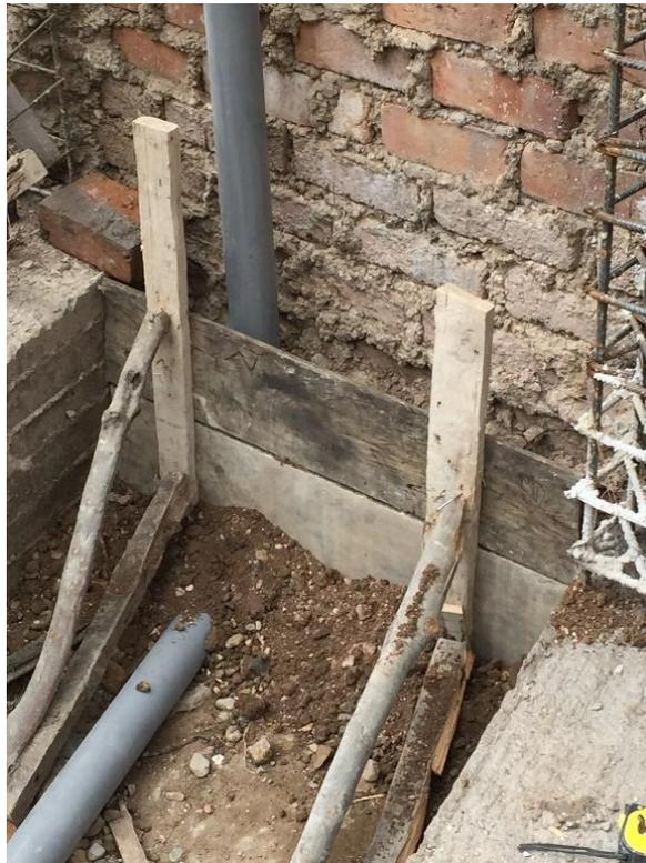
Se observa el mal apuntalado del encofrado del sobrecimiento, el material inorgánico en contacto con la mezcla.
