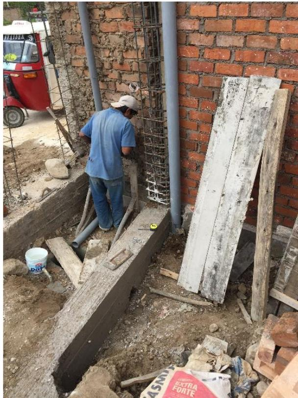
Se observa el inadecuado almacenamiento de encofrado, la falta de EPP y la falta orden en obra.
