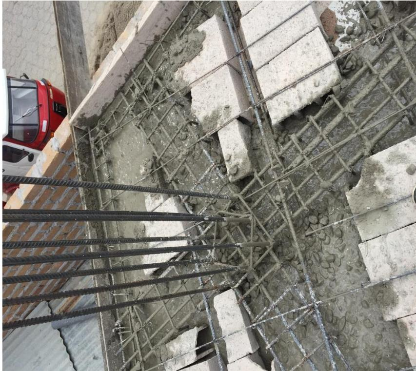
Se observa la mala construcción de la losa aligerada, sin ladrillos en algunos lugares o rotos.
