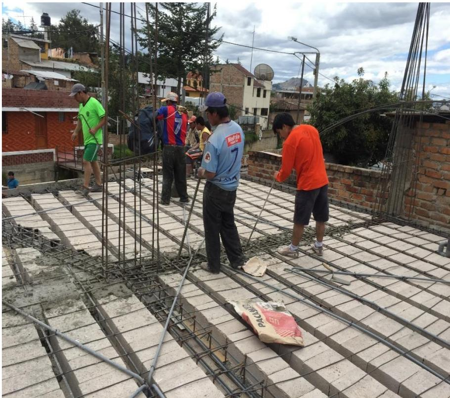
Se observa la forma artesanal en que se realiza el chuzado en las vigas y la falta de EPP
