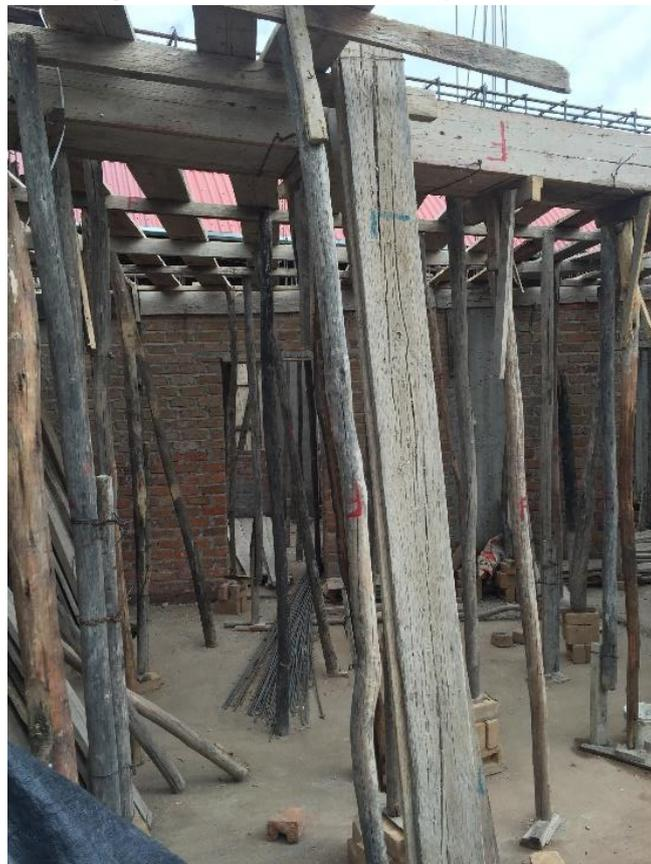
Se observa la mala colocación de los pies derechos, el desorden en el almacenamiento de acero corrugado
