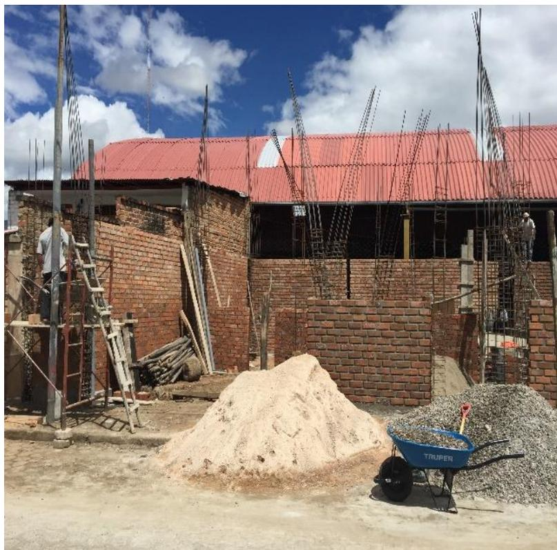
Se observa el acopio de material en la vía pública, el mal apoyo de los andamios y el desorden en obra.
