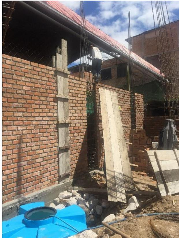
Se observa el mal almacenamiento del encofrado de columnas y la falta de equipo de trabajo en alturas (EPP)
