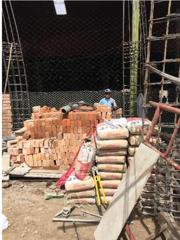
Se observa el incorrecto almacenamiento de material y equipo provocando el desorden en obra
