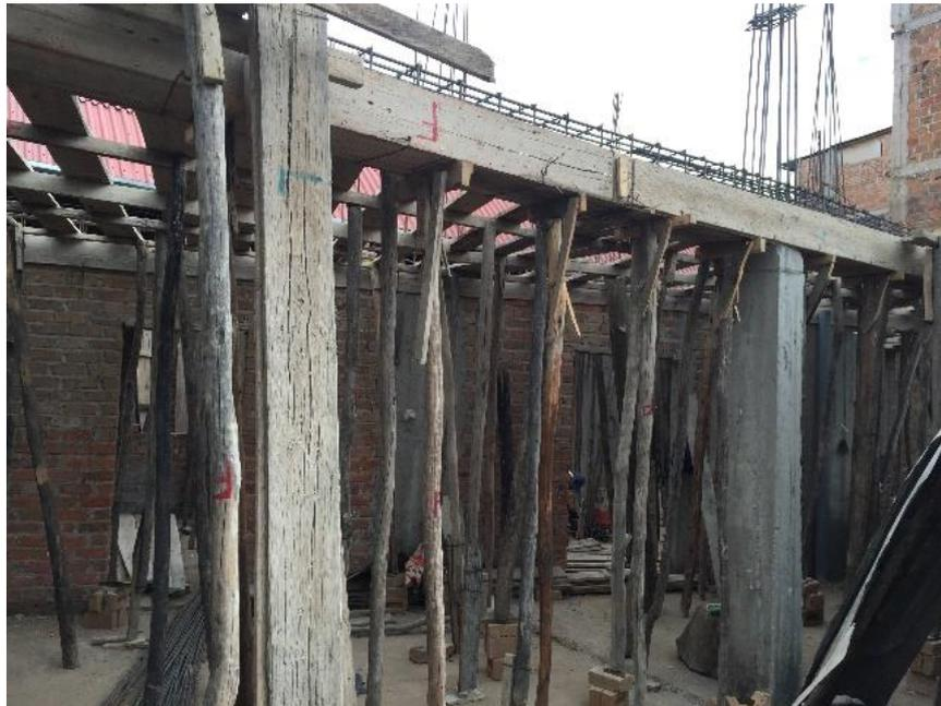
Se recomienda la utilización de pies derechos metálicos y encofrado metálico, ya que el utilizado está colocado en forma inadecuada
