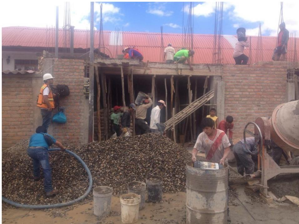
Se puede observar el lavado de agregado grueso en la vía pública y la falta de EPP en cada trabajador
