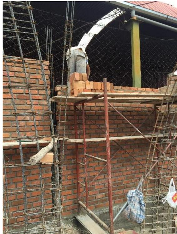
En obra se observa el inadecuado apoyo de andamios y la falta de equipo de protección personal
