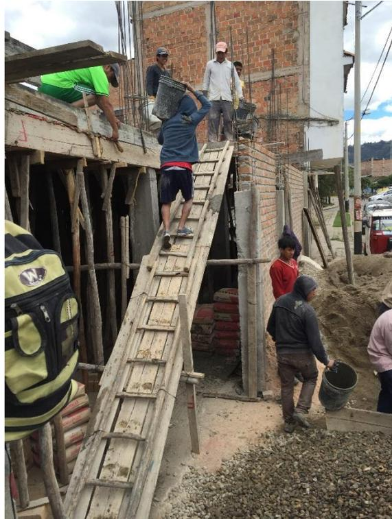
Se puede observar la inadecuada construcción de la rampa de acceso para el vaciado de losa aligerada.
