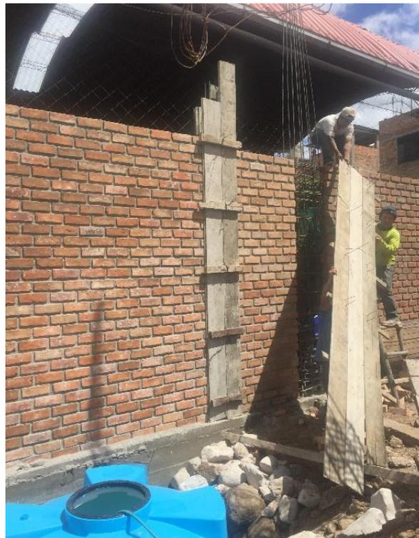
Se ve la forma improvisada en la que se realiza la colocación de encofrado de columnas.
