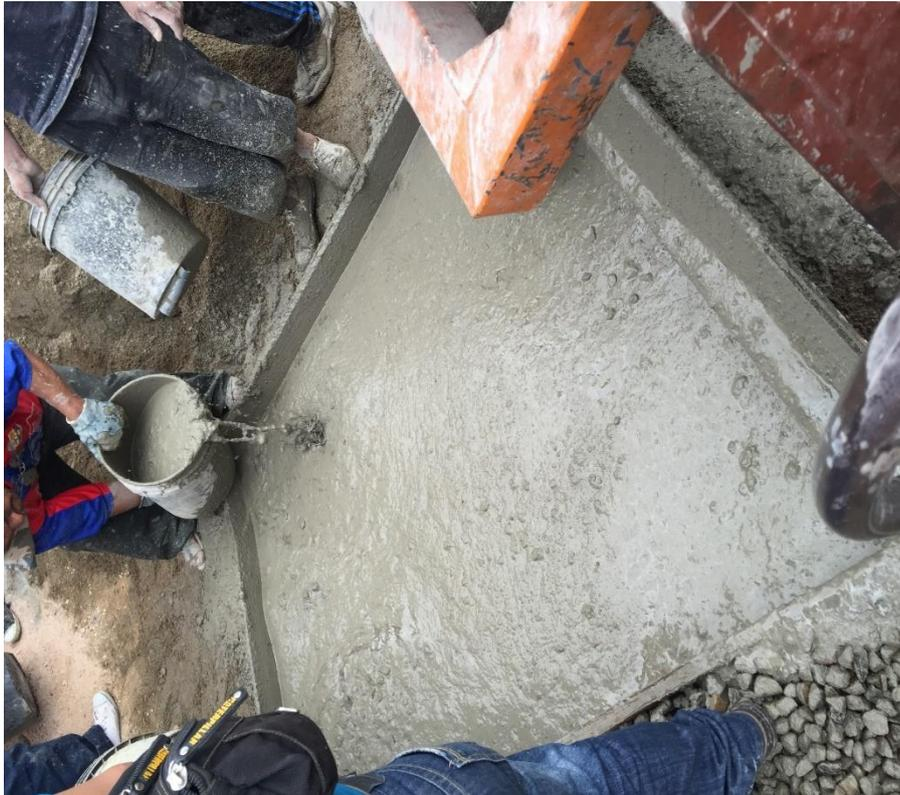
Se observa que la mezcla para la losa aligerada es demasiado fluida y con cuenta con un diseño de mezcla.
