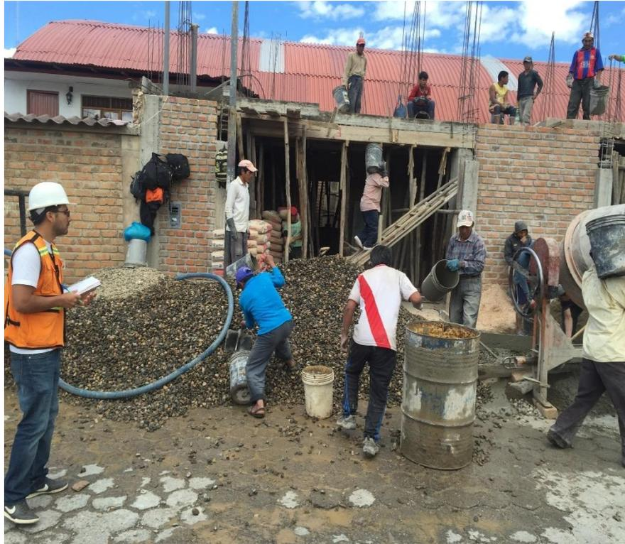
Se observó el acoplo de material en la vía pública, la falta de EPP y la mala distribución del personal.
