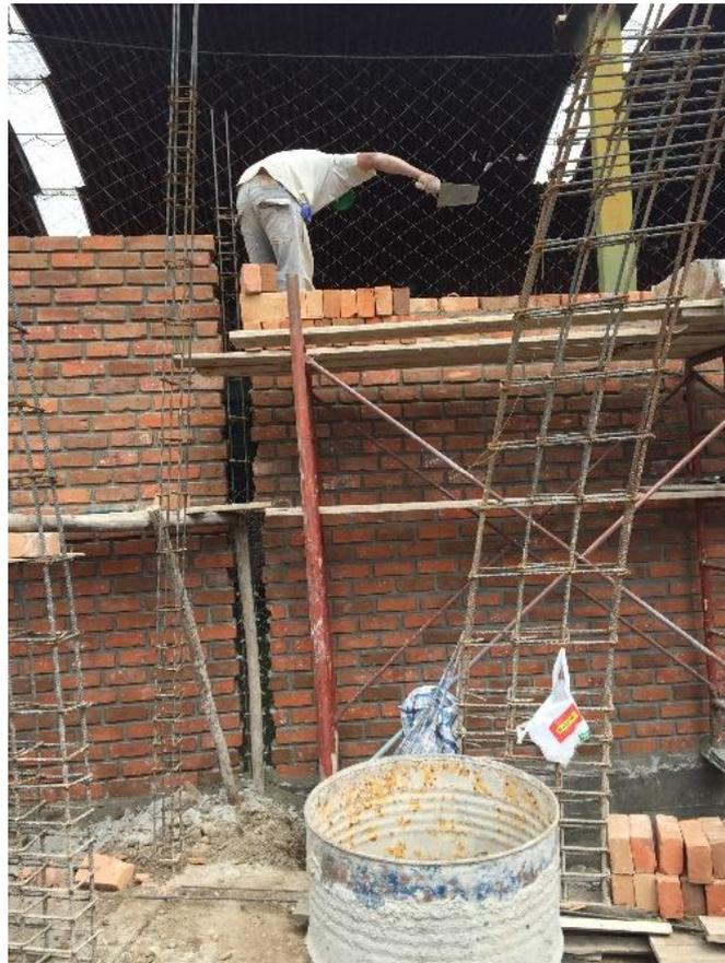
Se observa la falta de EPP, el reducido espacio para realizar el trabajo y el mal apoyo del andamio.
