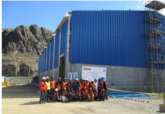
Figura 33: Proyecto de construcción de estructura metálica en polideportivo en Minera Chinalco
