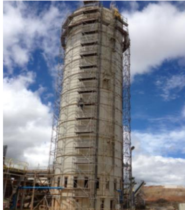
Figura 25: Reparación de Silo de Cal: Cambio de anillo superiores de Cal en planta de procesos – Gold Mill, Minera Yanacocha.
