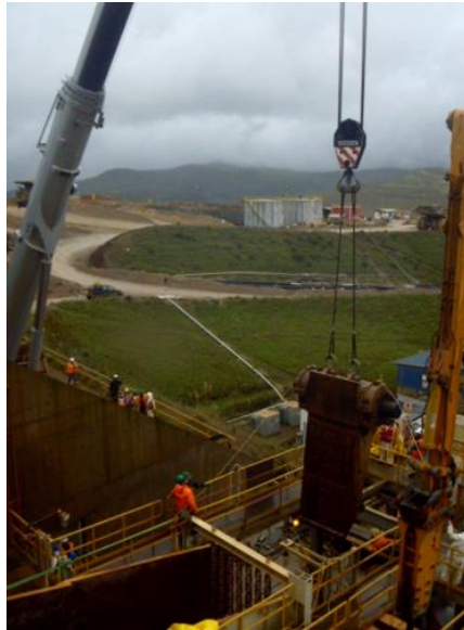
Figura 19: Cambio de pitman, Fajas, Zaranda Grizzly
