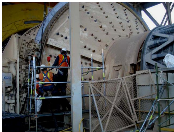
Figura 18: Cambio de Liners de MOLINO SAG
