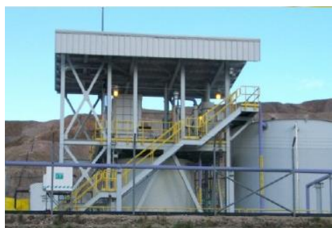
Figura 34: Montaje de estructura e instalación de Cobertura
