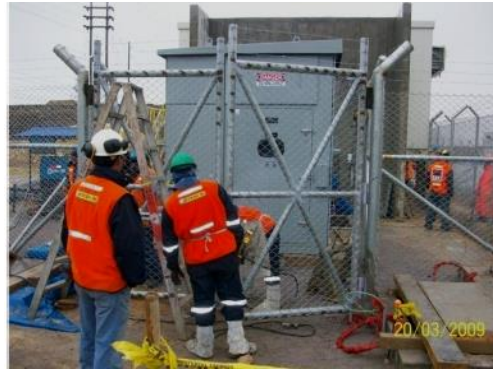
Figura 35: Instalaciones de tendidos eléctricos, construcciones de sub estaciones e instalaciones de postes e iluminación, aterramiento.
