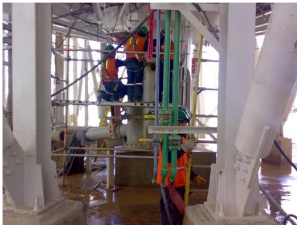
Figura 21: Cambio de válvulas
