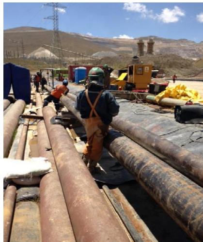
Figura 36: Cambio de tramos de tuberías
