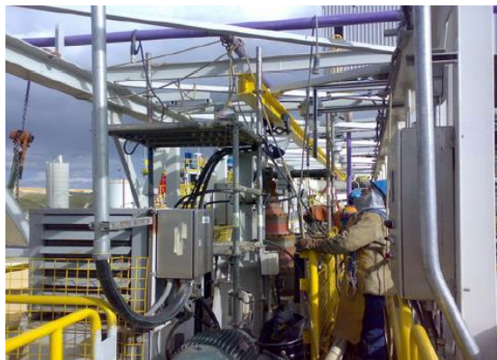
Figura 22: Cambio de Motor Hidráulico
