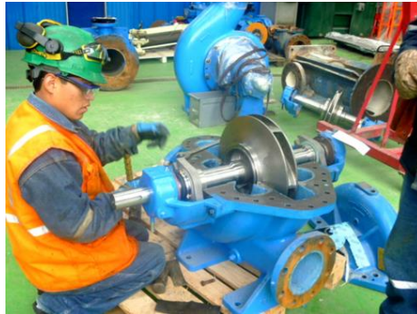
Figura 26: Reparación de Bombas Horizontales
