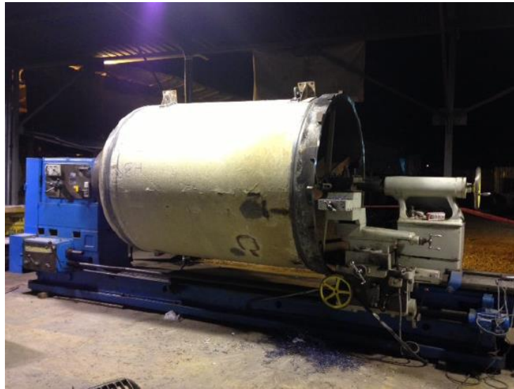
Figura 29: Recuperación de Tanques: Trabajo de reparación de Filtro Clarificador.
