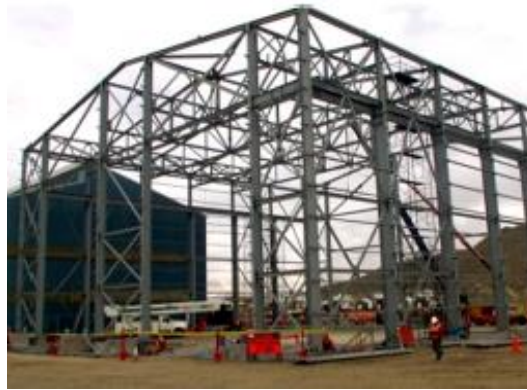
Figura 32: Diseño, cálculo, construcción y montaje de almacén
