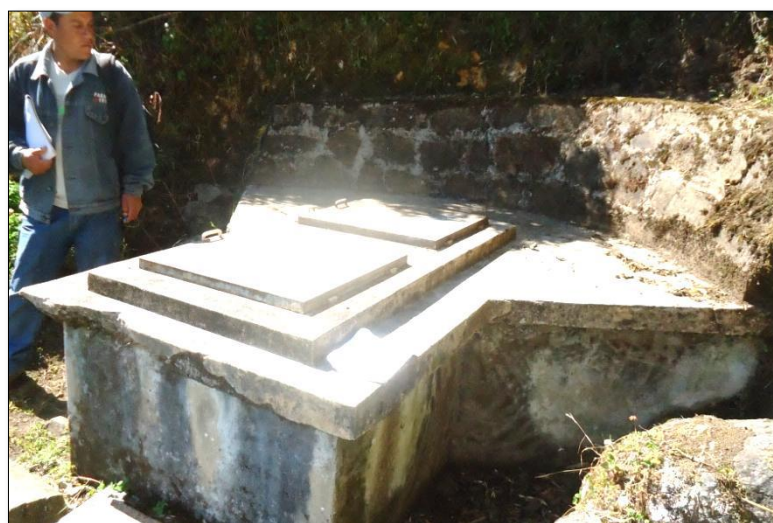
Foto N° 11. Toma de concreto.
