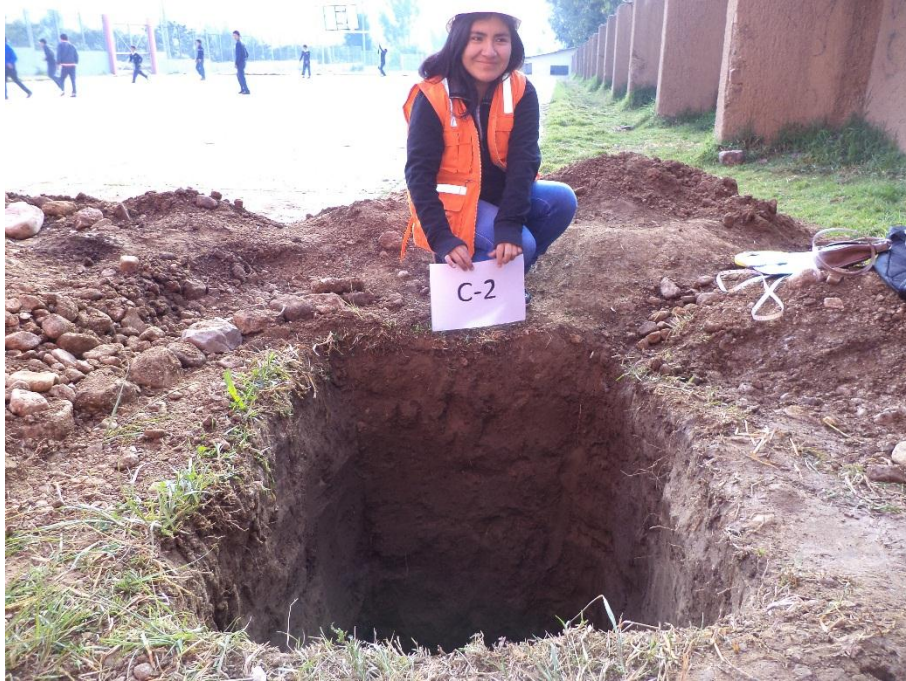
Figura N° 7.21. Calicata N°02, ubicada a un costado del módulo “C” de tres niveles.
