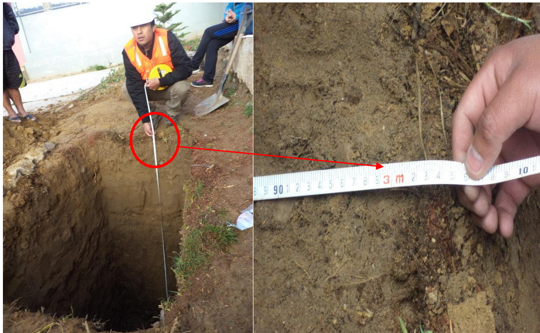
Figura N° 7.20. Calicata N°01, profundidad 3.00m.
