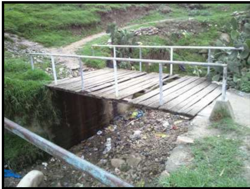
Fotografía N° 09. Puente construido en la prolongación de la avenida Perú.
