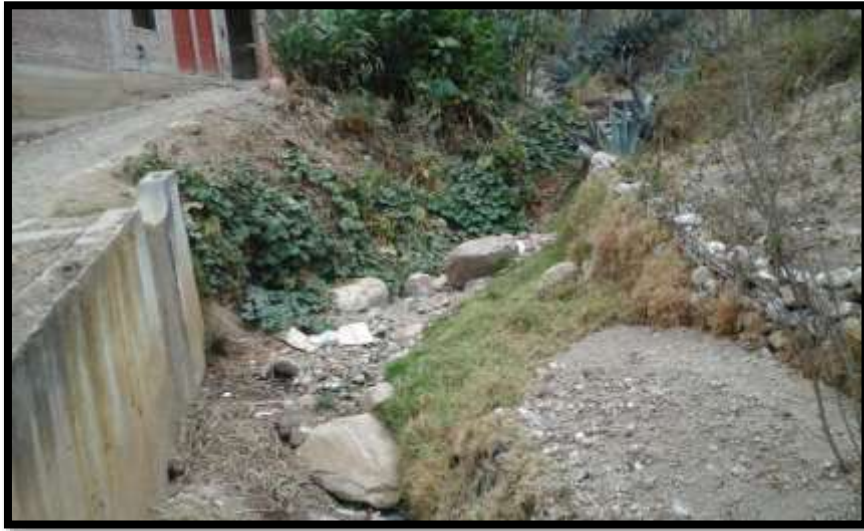
Fotografía N° 14. Estado actual de la quebrada Calispuquio.
