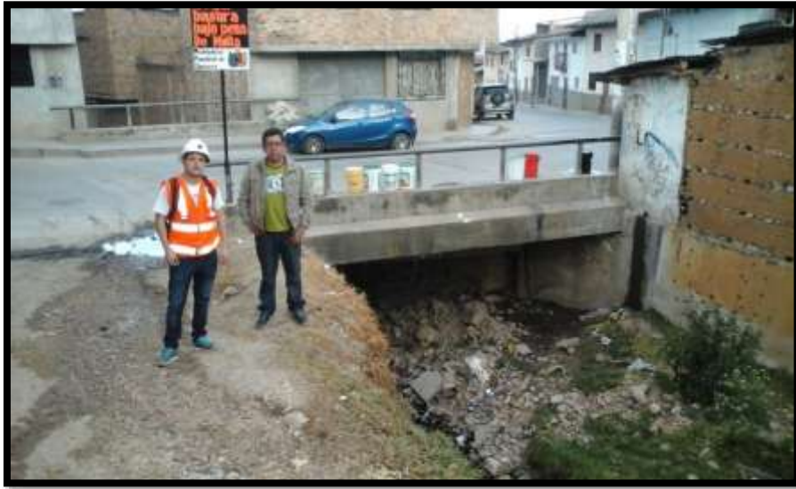
Fotografía N° 06. Quebrada que pasa intersectando la avenida Los Manantiales en la cual se observa que las casas aledañas vierten sus aguas servidas a la quebrada.
