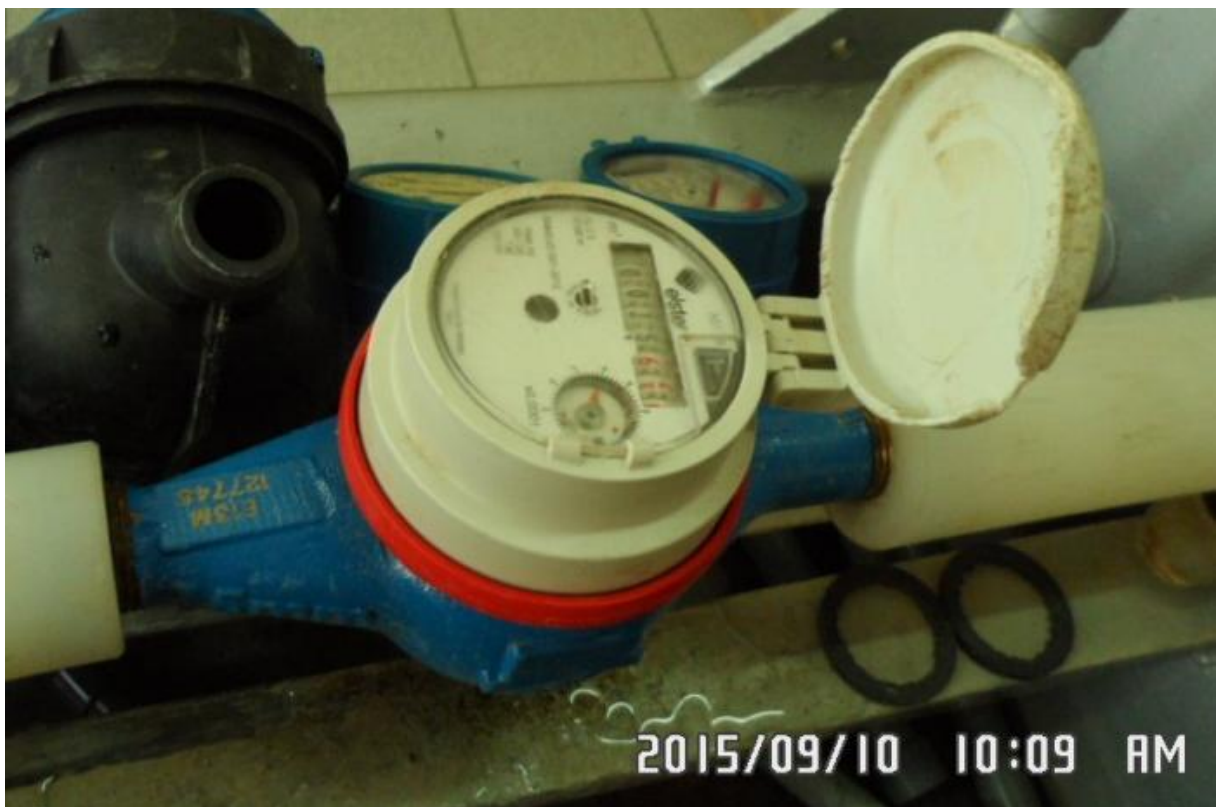
Medidor con tapa carcomida por roedores.
