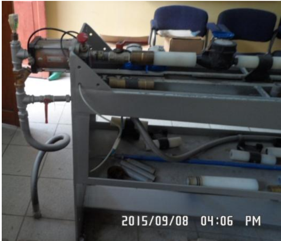
Ingreso del agua al banco de medidores
