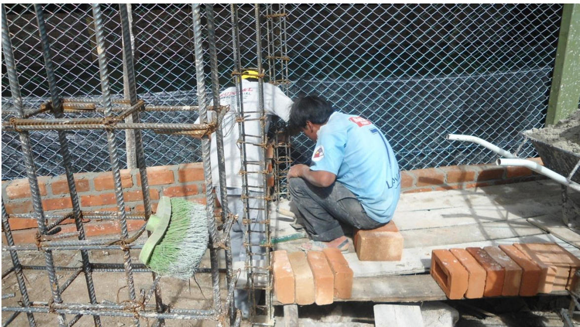
FOTO N° 19: Asentado De Ladrillos
