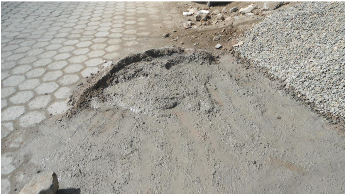
FOTO N° 17: Material Sobrante Del Vaciado De Vigas De Cimentación
