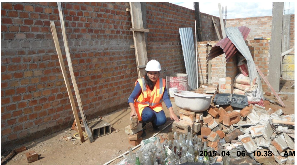
FOTO N° 04: Realizando El Conteo Del Material Sobrante
