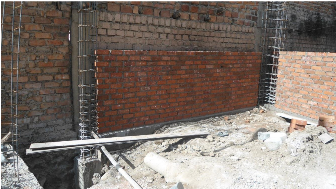
FOTO N° 21: Asentado De Ladrillos En Muro de Albañilería
