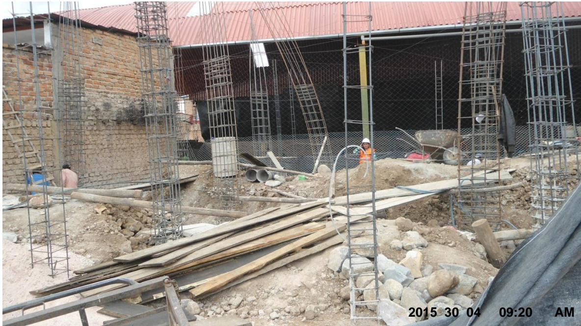
FOTO N° 07: Acumulación de madera Para Encofrados
