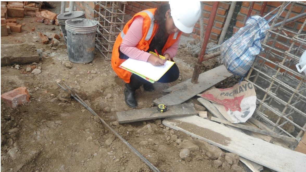
FOTO N° 27: Toma De Medidas De Desperdicios De Madera
