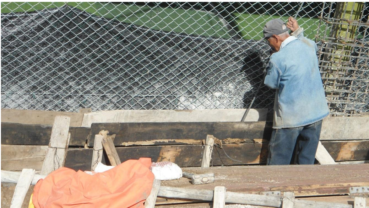
FOTO N° 15: Compactación De Concreto En Vigas De Cimentación
