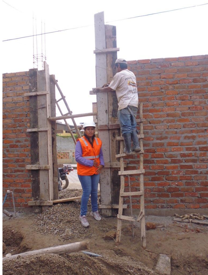
FOTO N° 23: Encofrado De Columnas
