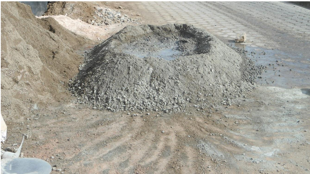
FOTO N° 13: Preparación De Material
