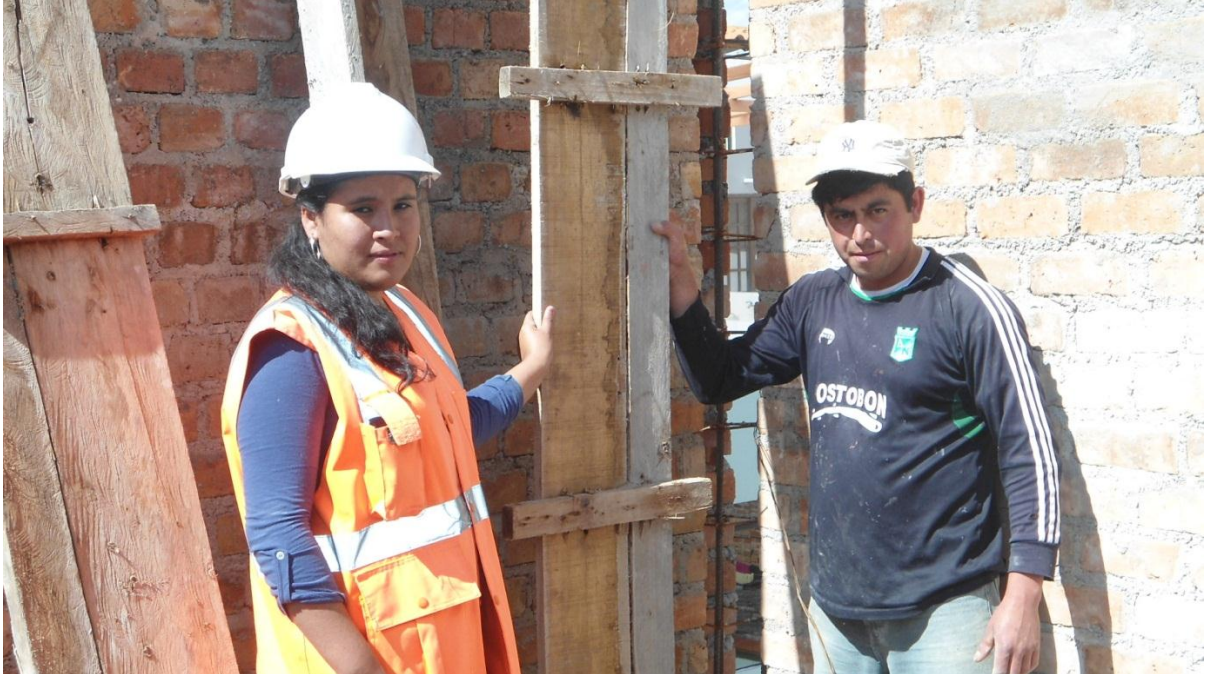
FOTO N° 05: Encofrado De Columnas
