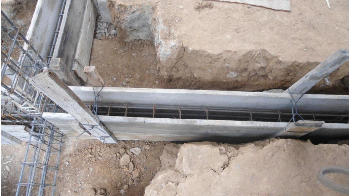
FOTO N° 28: Encofrado De Vigas De Cimentación
