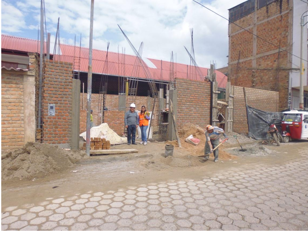
FOTO N° 24: Preparación De Material
