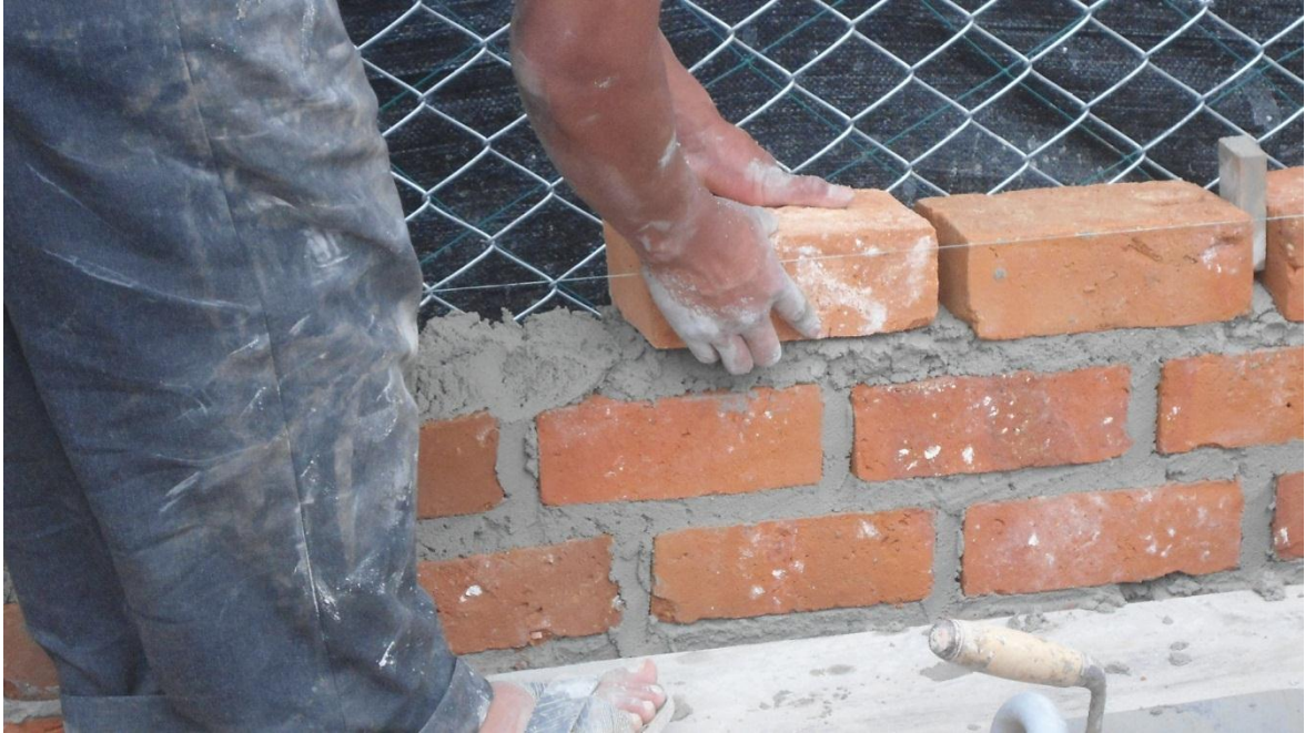
FOTO N° 20: Asentado De Ladrillos
