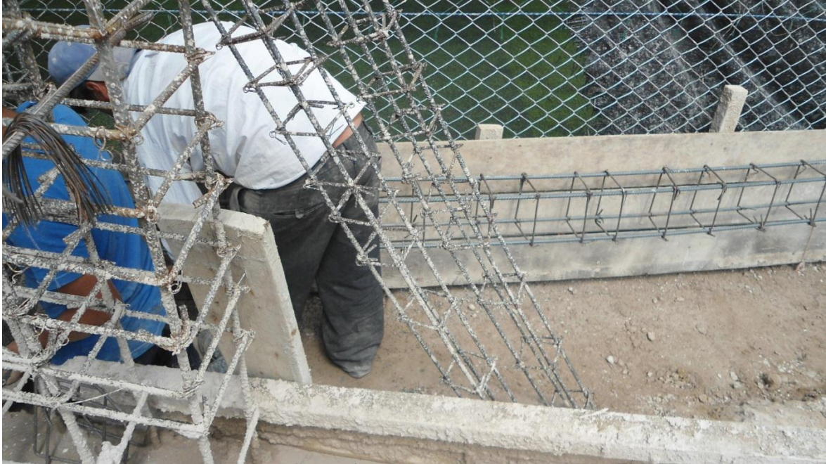
FOTO N° 12: Encofrado De Vigas De Cimentación
