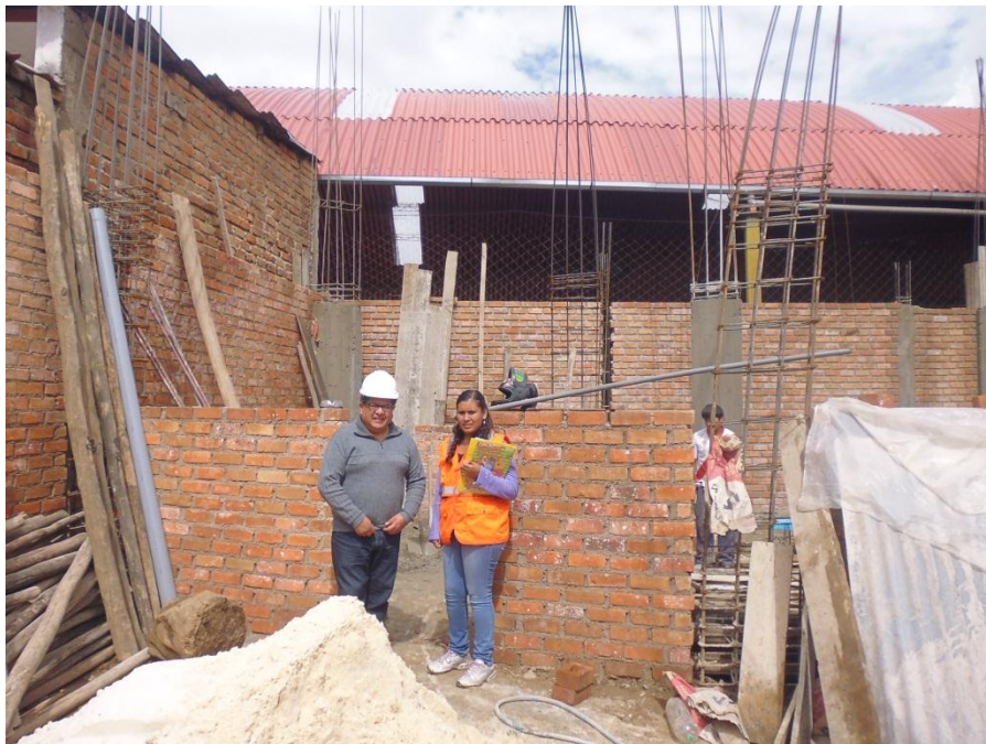
FOTO N° 25: Asentado de Ladrillo
