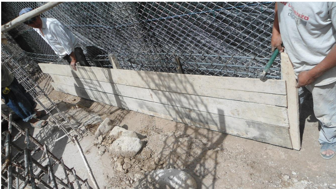
FOTO N° 11: Encofrado De Vigas De Cimentación
