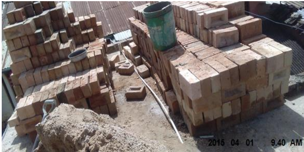
FOTO N° 01: Ladrillos Almacenados Al Interperie
