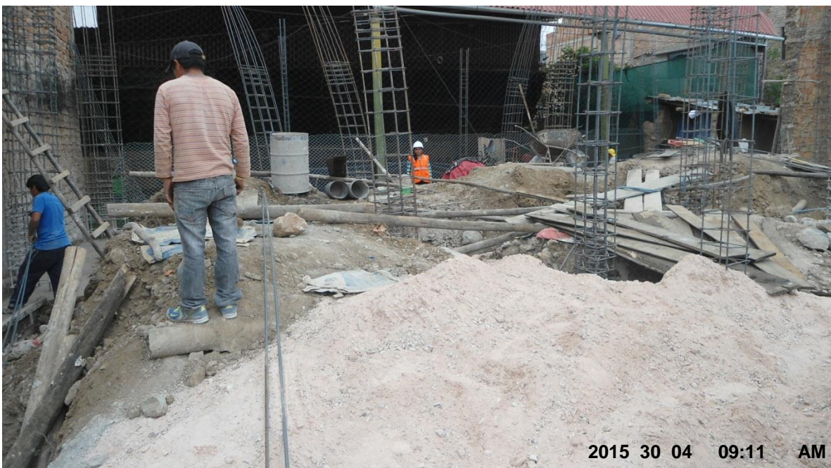
FOTO N° 06: Encofrado de Vigas de Vimentación
