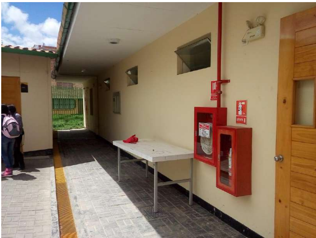
Corredor externo para acceder al laboratorio de hidráulica
