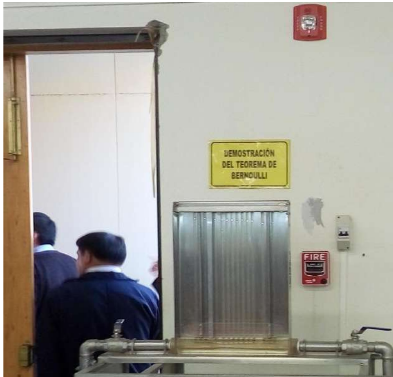
Fotografía 3: Ubicación de alarma
