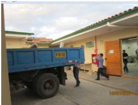
Figura N° 67: Se puede ver como se botó todas las probetas ensayadas y demás materiales usados para su eliminación.
