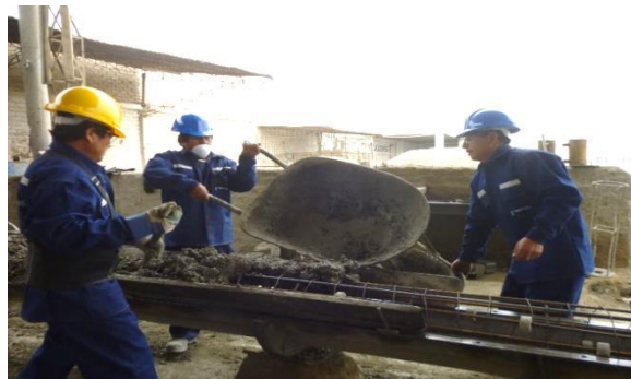
IMAGEN N° 05: VACIADO DE MEZCLA
