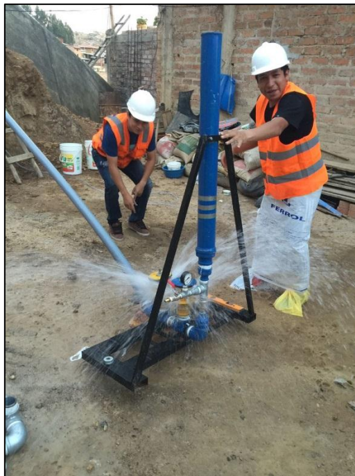
Fotografía N° 24: Segundo ensayo realizado en campo; en el que se observa la puesta en marcha del sistema hidráulico trabajando con dos válvulas de impulsión distribuidos en serie.
