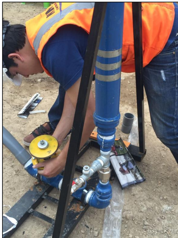
Fotografía N° 20: Segundo ensayo realizado en campo; en el que se observa el ensamblaje de las válvulas de impulsión.
