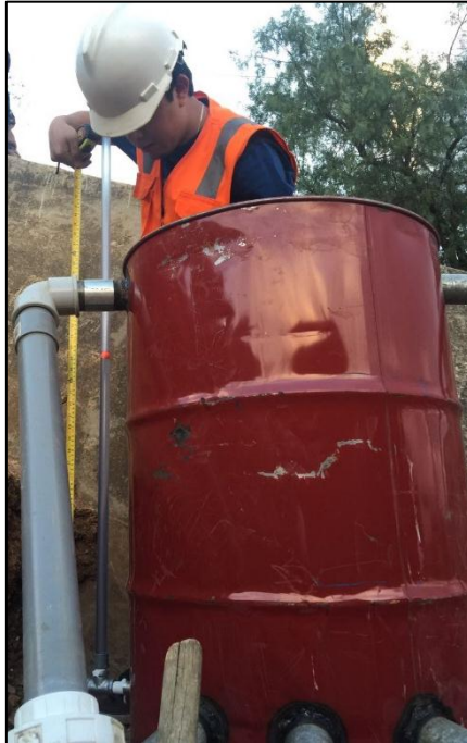
Fotografía N° 23: Segundo ensayo realizado en campo; en el que se observa la medición de la altura de suministro para el sistema hidráulico
