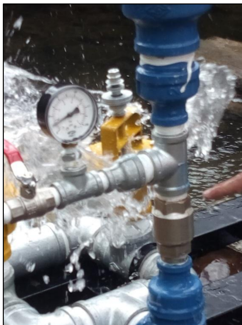
Fotografía N° 42: Quinto ensayo realizado en campo en el Viaducto de Los Baños del Inca, en el que se observa una presión acumulada de 15 psi. para la puesta en marcha de la bomba de ariete hidráulico trabajando con válvulas en paralelo.
