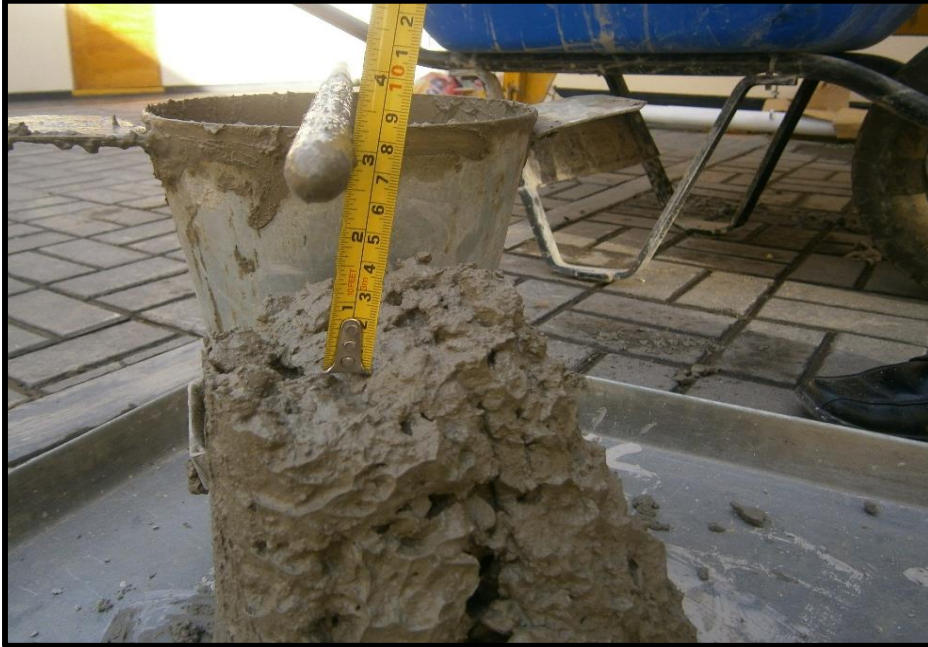
FOTOGRAFIA N° 31. Ensayo para medir el asentamiento o Slump.
