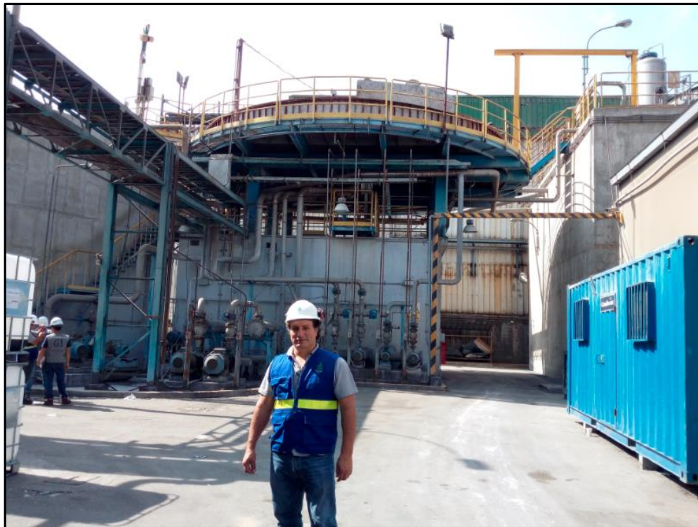
Figura n.º 3-7. Vista General de la Planta de Clarificación Primaria.
