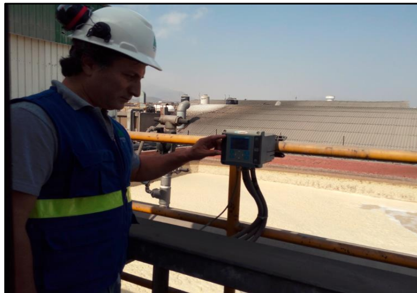
Figura n.º 3-11. Equipo medidor de Oxígeno del tanque reactor.
