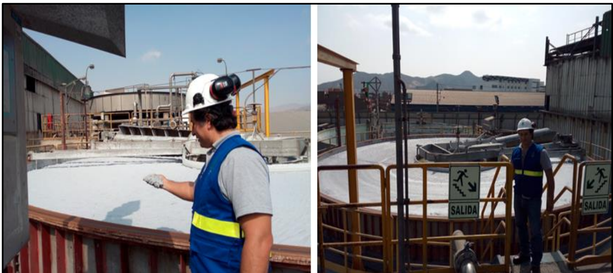
Figura n.º 3-8. Vista del Deltafloat en operación.
