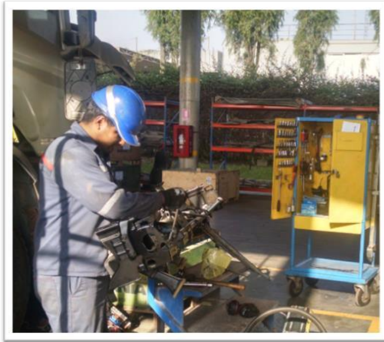
Figura n.º 3-13 Armado de cabina y componentes varios
