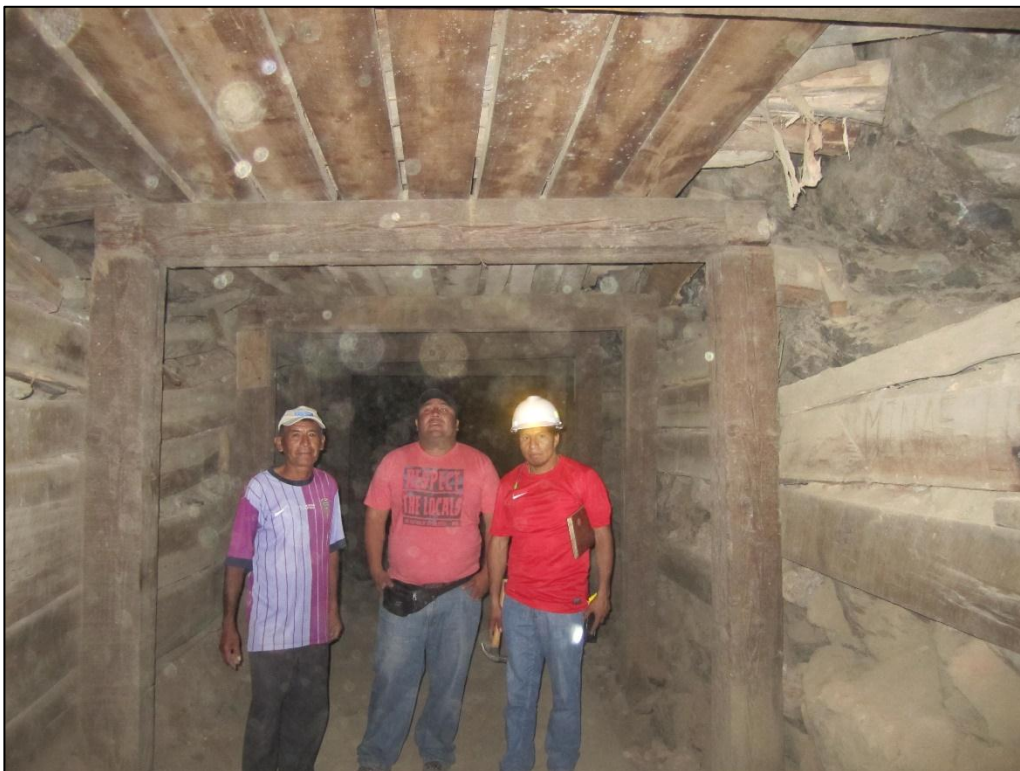
Figura 37: Sostenimiento del socavón.
