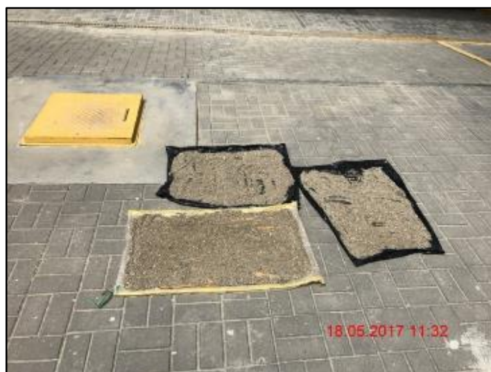
Fotografía N° 6: Secado del agregado fino
