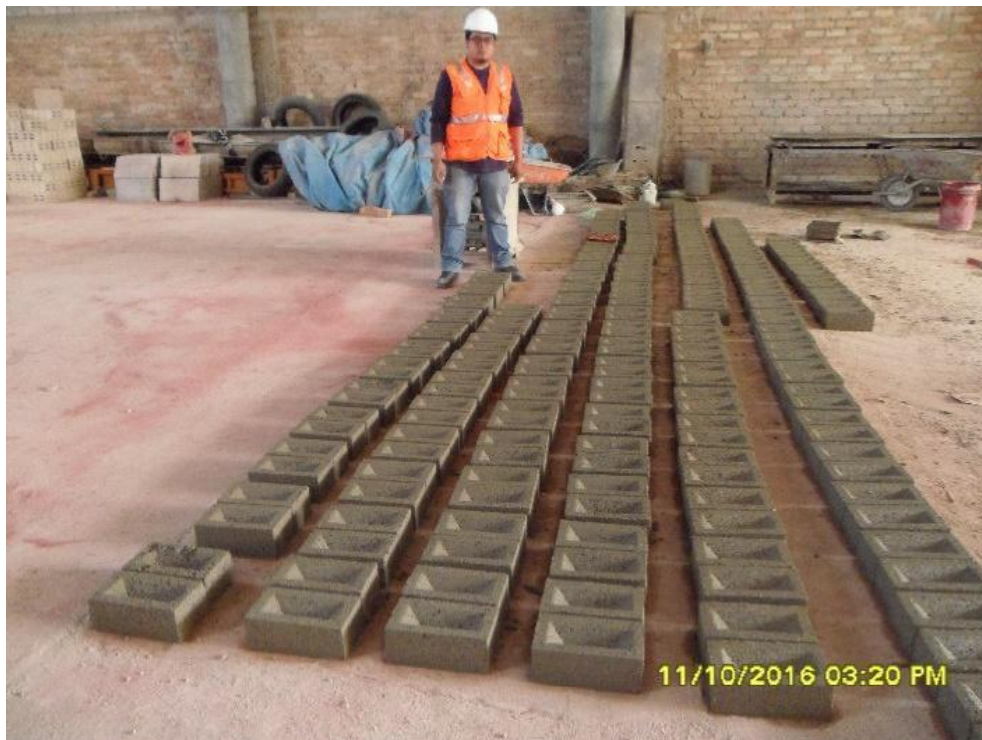
Figura n.º 178. Culminación de la elaboración de ladrillos.
