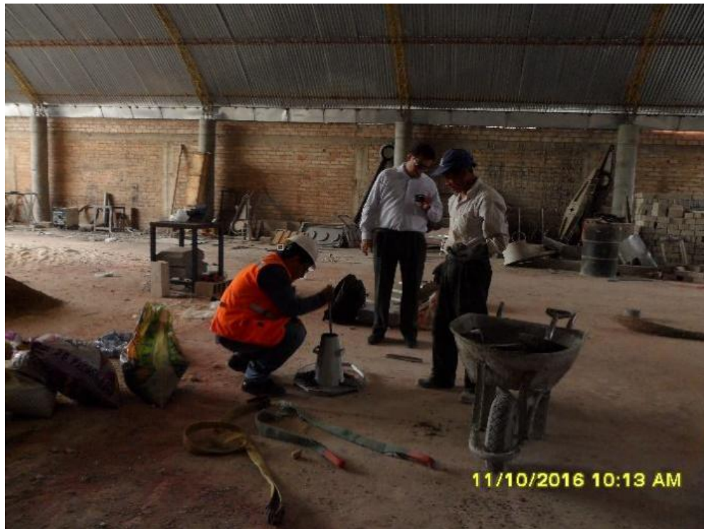
Figura n.º 175. Realizando prueba de consistencia de la mezcla.
