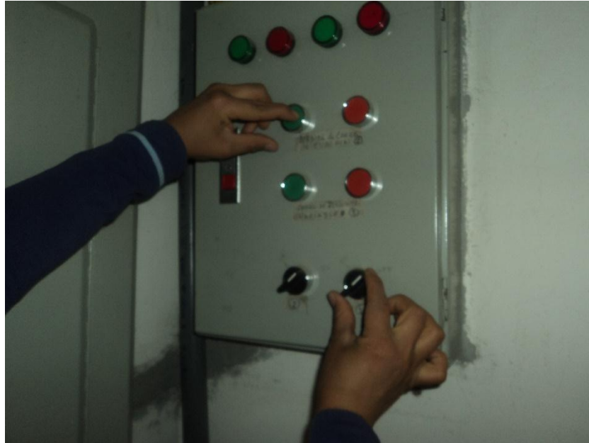
Figura n° 32. Ponemos en marcha la electrobomba.
