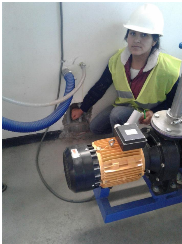
Figura n° 73. Abriendo la válvula de la red general.
