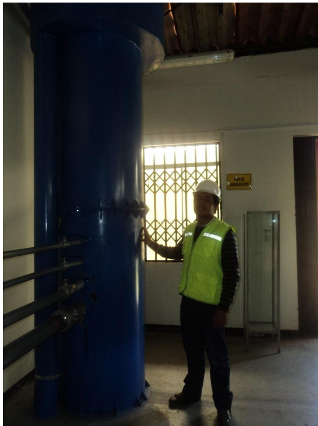
Figura n° 33. Llenamos la cisterna manteniendo una carga constante.
