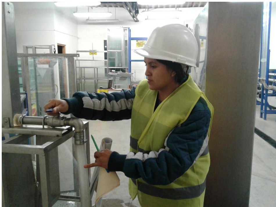
Figura n° 51. Abrimos la válvula compuerta.
