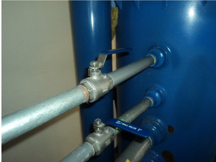
Figura n° 34. Abrimos la válvula de entrada de agua para la tubería que deseamos ensayar.
