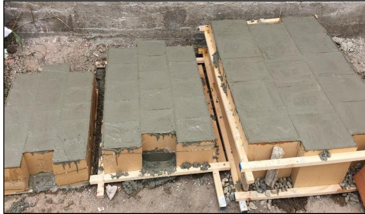
Colocación de la mezcla de concreto en los moldes metálicos
