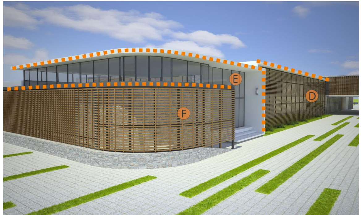
Figura N° 26: Protección Fachada Norte y Este
