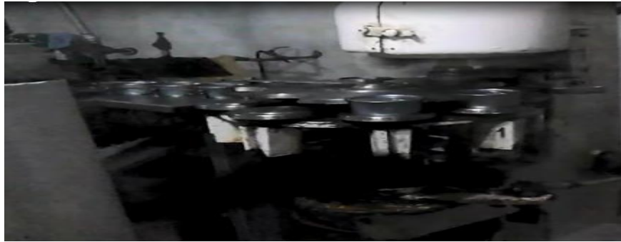
Figura n°23: Cerradora en mal estado
