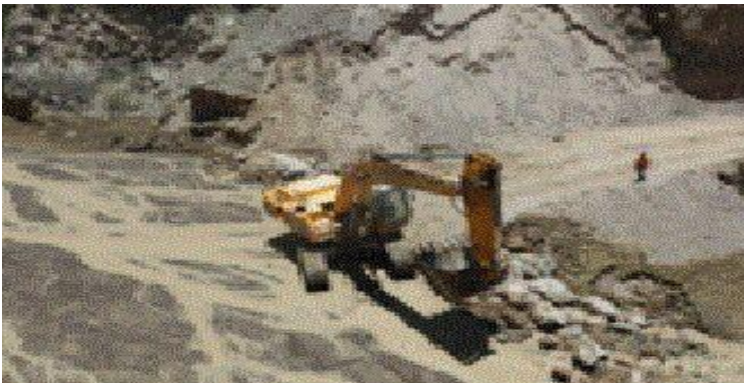
Figura 22. Trabajos en carretera
