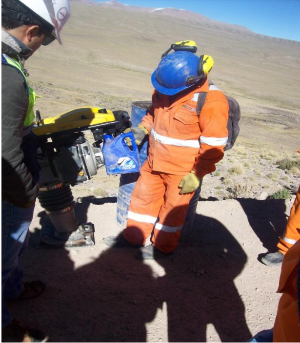
Figura 32. Visita al corredor vial
