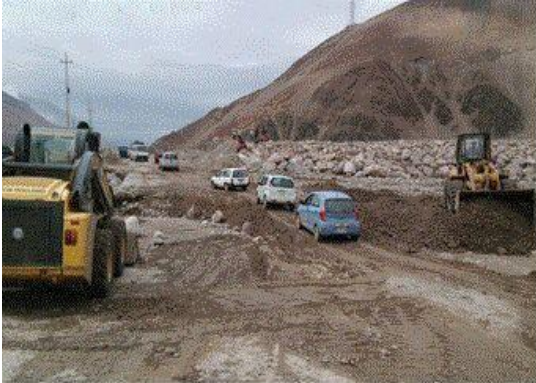
Figura 21. Carretera en construcción región Arequipa
