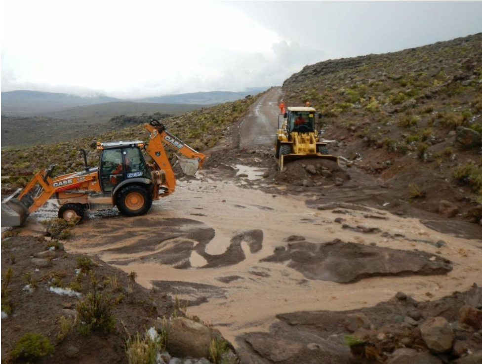
Figura 23. Trabajos en carretera región Arequipa
