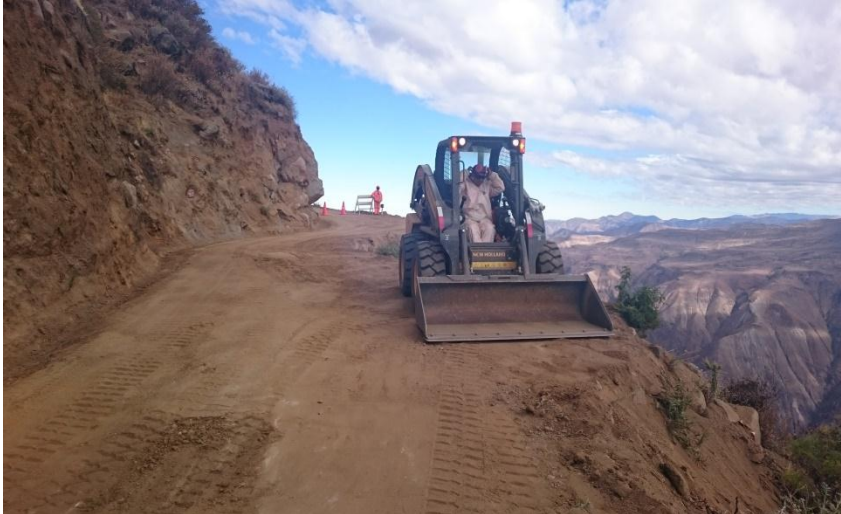
Figura 33. Visita al corredor vial
