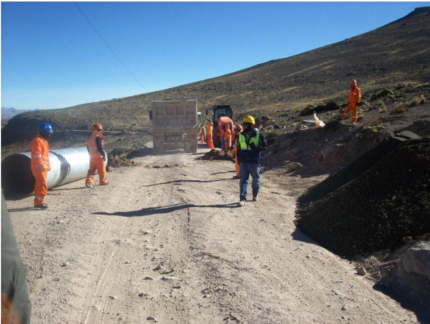
Figura 29. Visita al corredor vial
