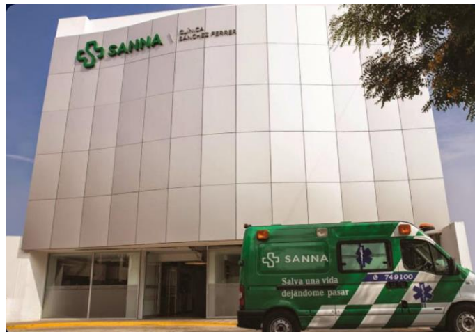
Figura Nº 1: Frontis de la empresa Clínica Sánchez Ferrer S.A.
