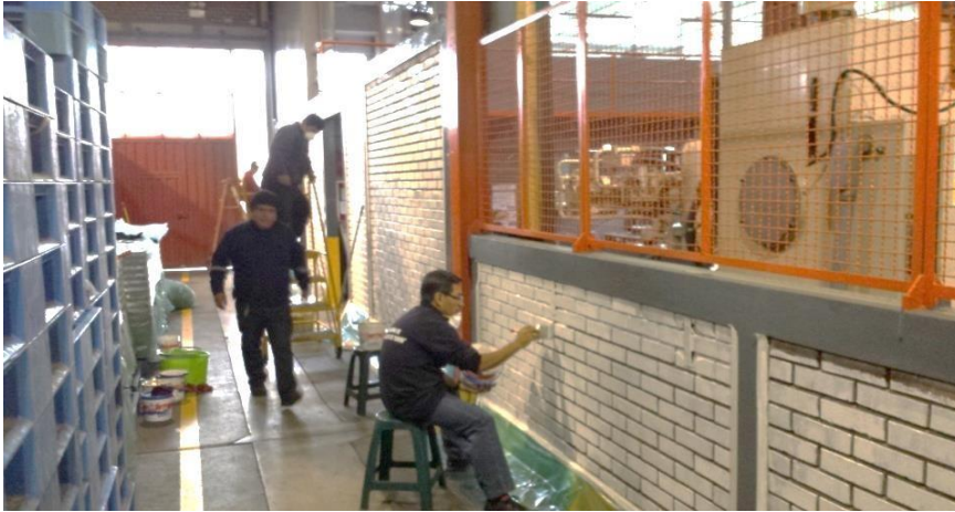
Figura.3.6.2. Limpieza y pintado del área
