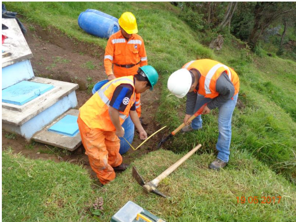
Figura n°. 49: Verificando el trazo para excavación – captación 1.
