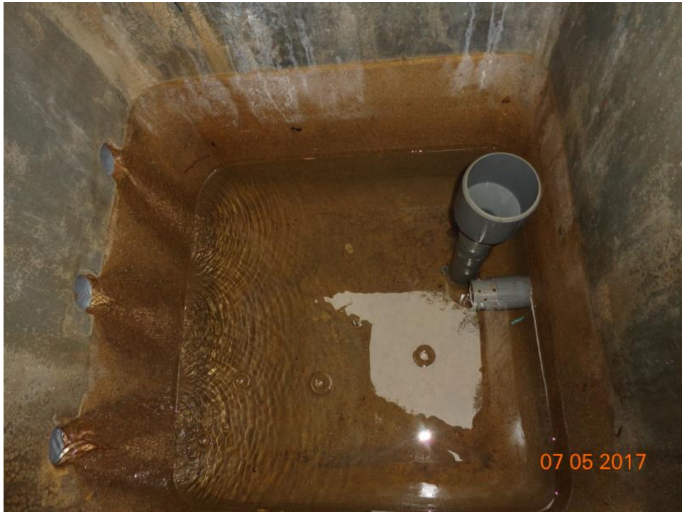
Figura nº. 40: Estado actual de la cámara húmeda - captación 2.
