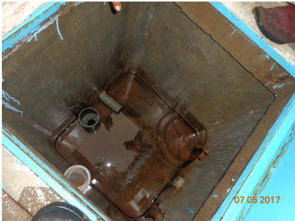
Figura nº. 37: Estado actual de la cámara húmeda - captación 1.
