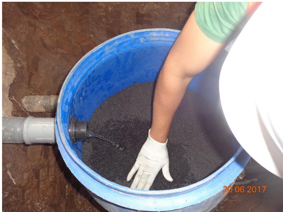
Figura nº. 64: Colocación del carbón activado
