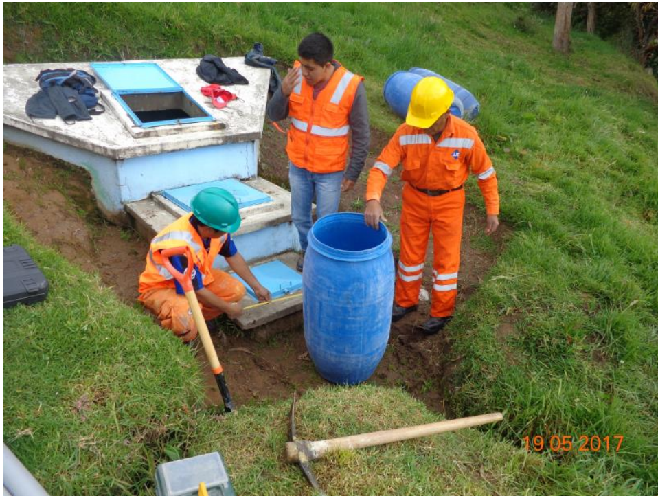
Figura n°. 48: Realizando el trazo para excavación – captación 1.
