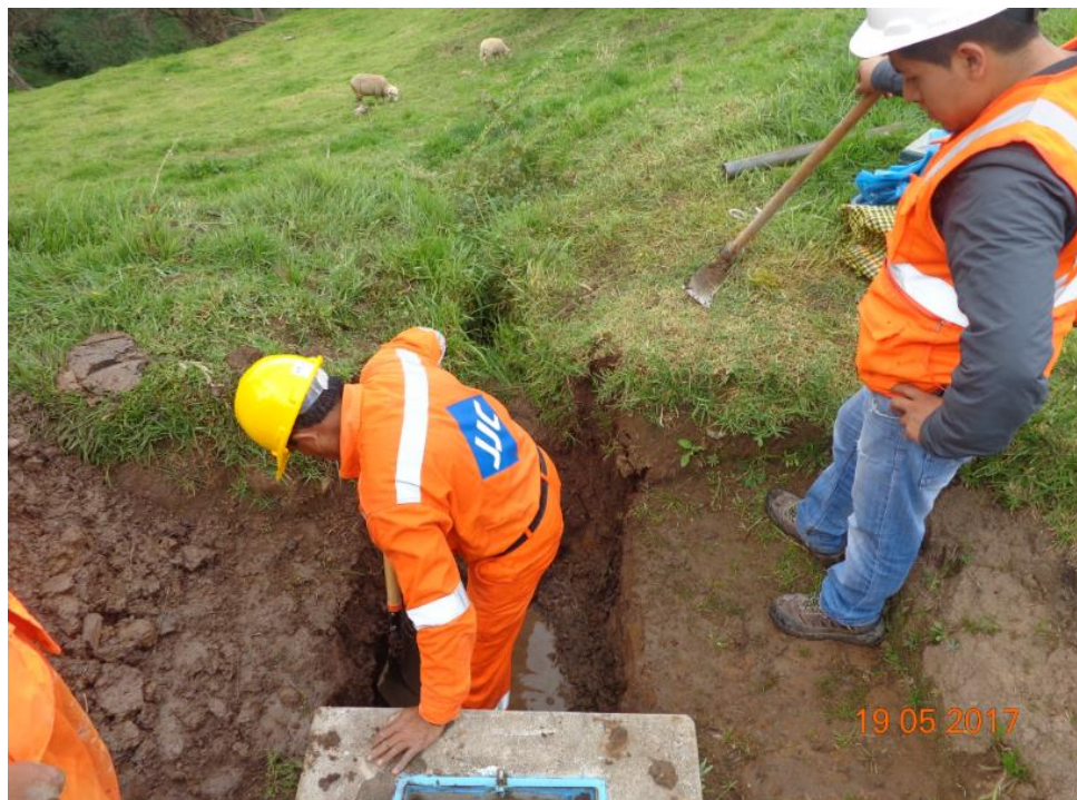
Figura nº. 53: Inicio de excavación - captación 1
