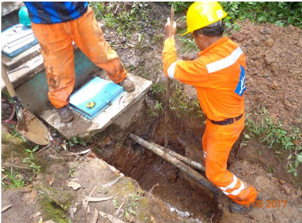
Figura nº. 55: Tubería existente - captación 2.
