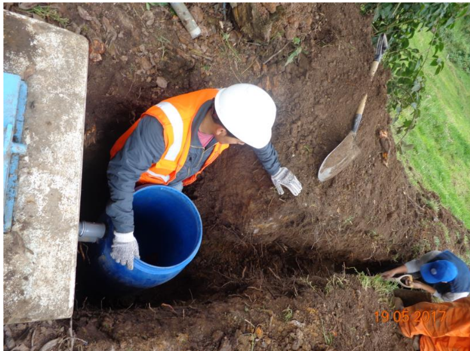
Figura nº. 59: Realizando la instalación del tanque - captación 3.
