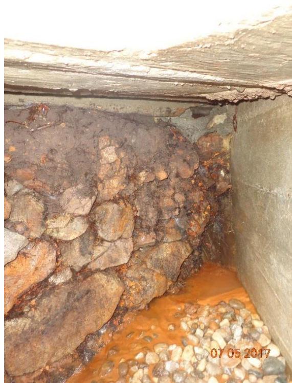
Figura nº. 39: Estado actual de la captación 2.
