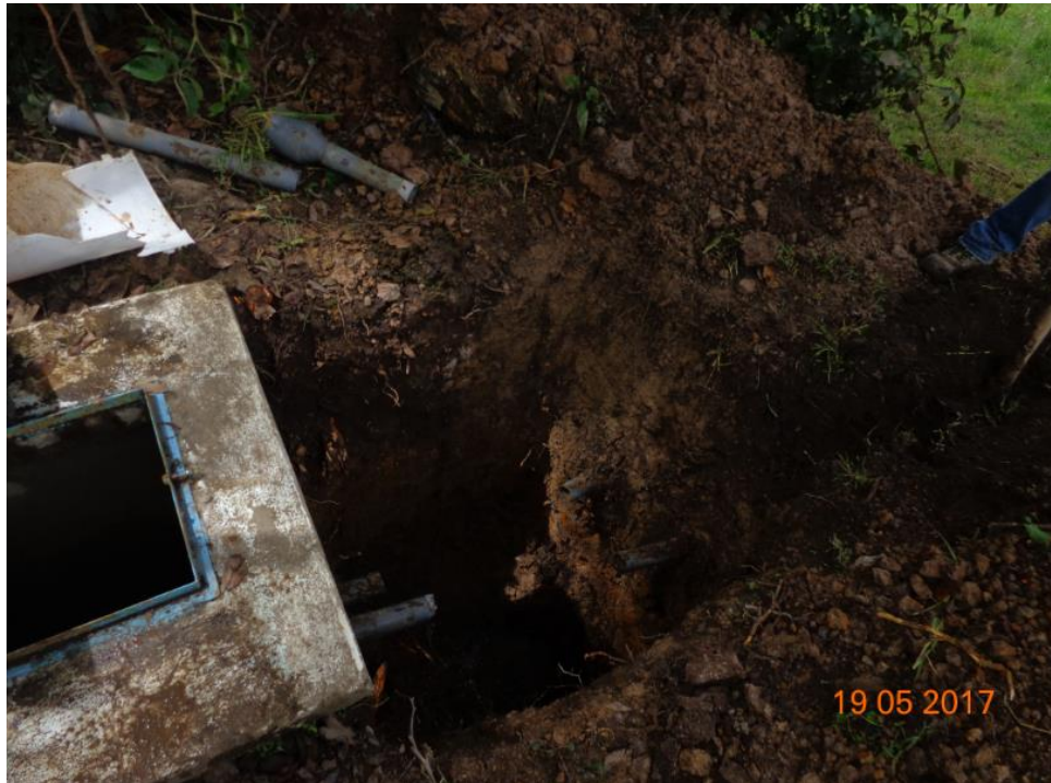
Figura nº. 56: Corte de tubería existente - captación 3.
