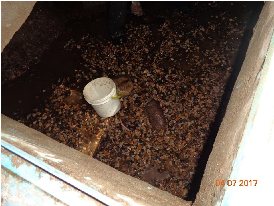
Figura nº. 70: Mejoramiento de la captación tras recomendaciones del Ingeniero Orlando Aguilar
