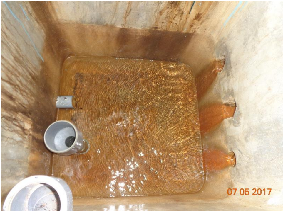
Figura nº. 43: Estado actual de la cámara húmeda - captación 3.
