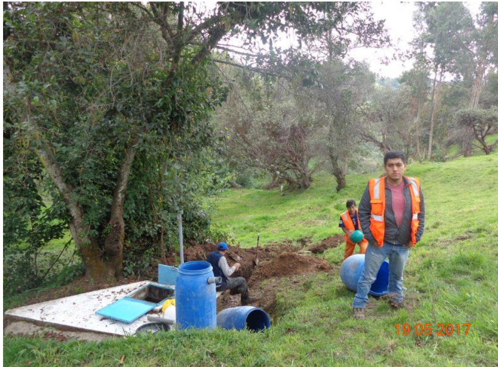
Figura nº. 58: Avance de excavación de zanja - captación 3.
