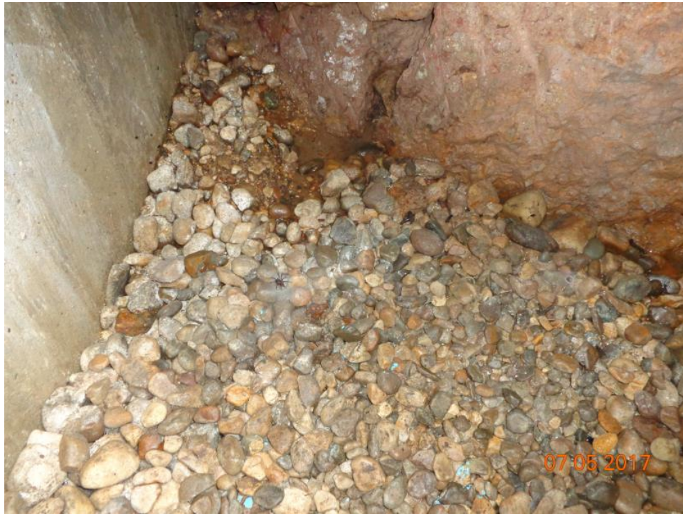
Figura nº. 42: Estado actual de la captación 3.
