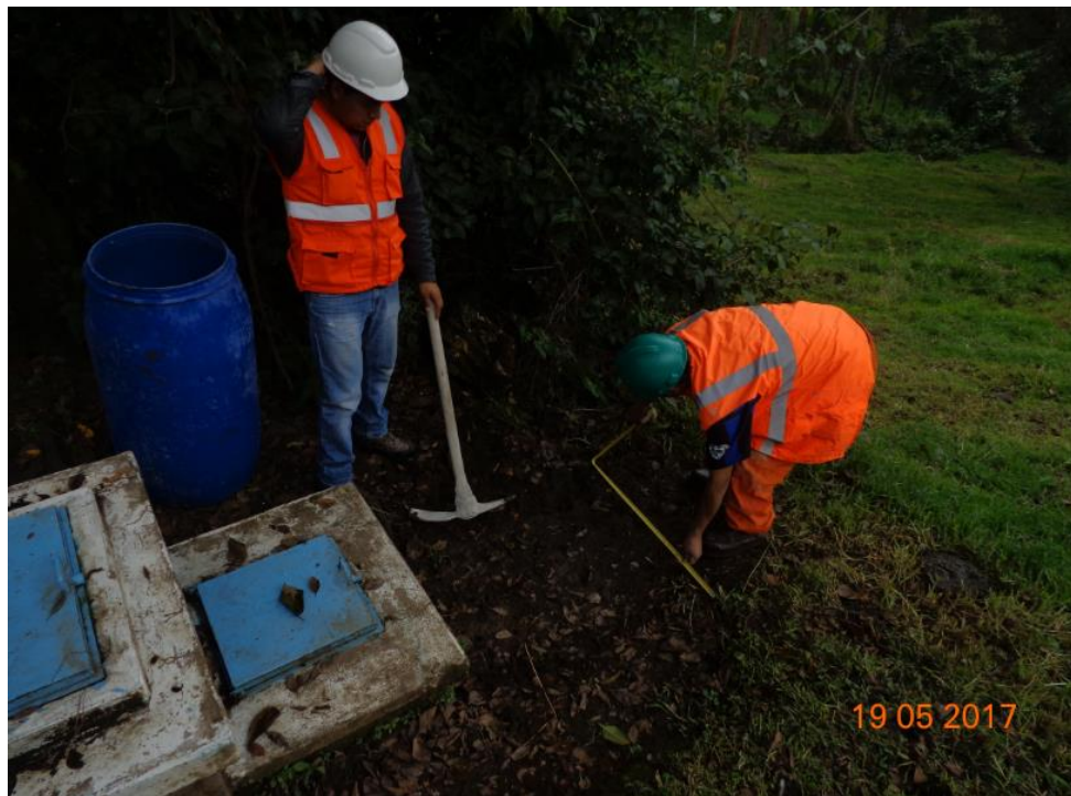
Figura nº. 52: Verificando el trazo para excavación – captación 3.
