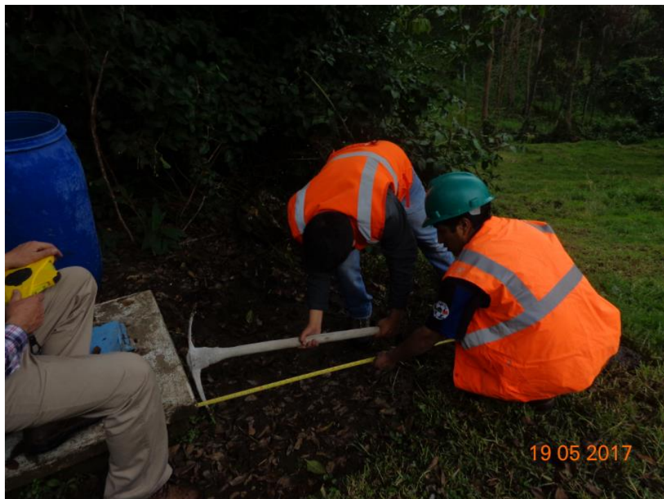
Figura nº. 51: Realizando el trazo para excavación – captación 3
