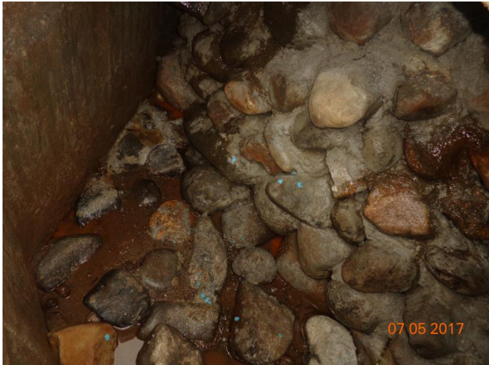
Figura nº. 36: Estado actual de la captación 1.
