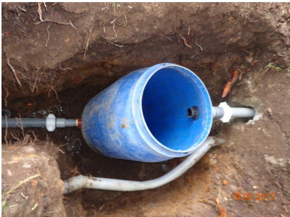
Figura nº. 61: Tanque instalado - captación 3.
