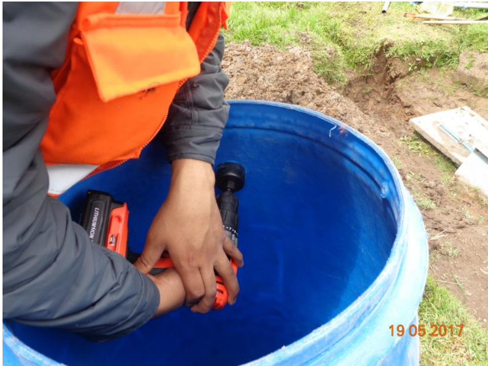
Figura nº. 54: Instalación de accesorios al tanque.
