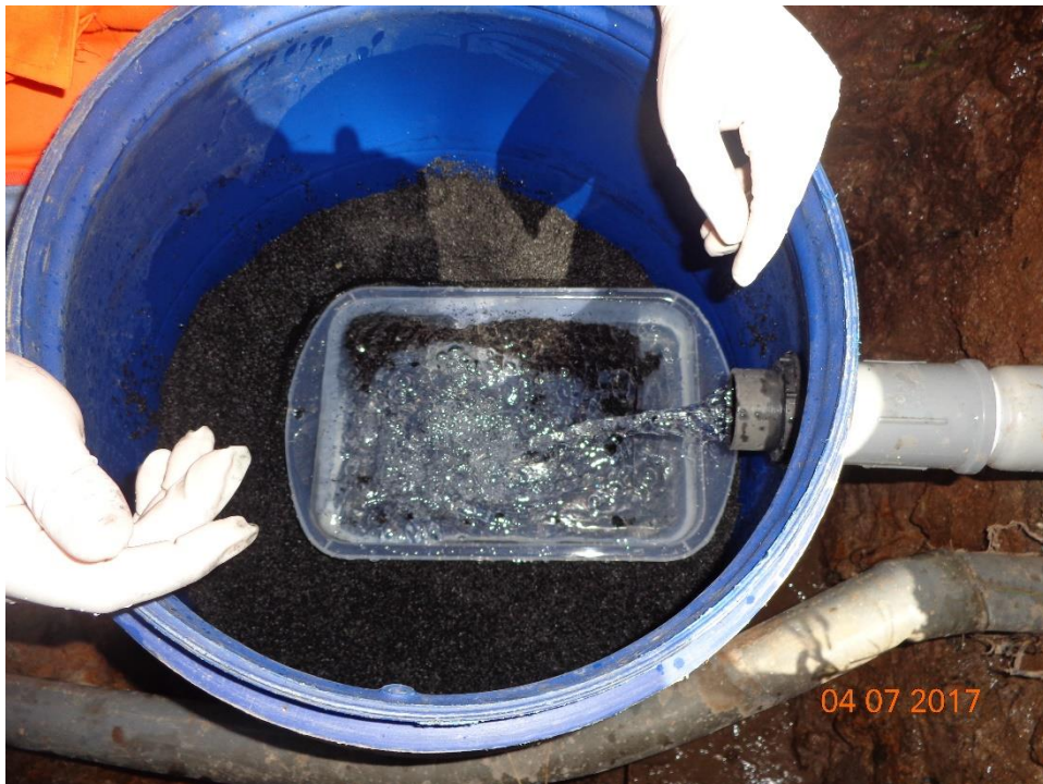
Figura nº. 71: Base para la caída del agua
