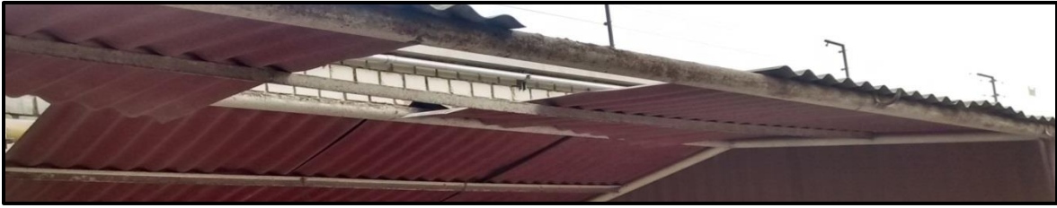
Imagen N° 06: Desperdicio de la materia prima
