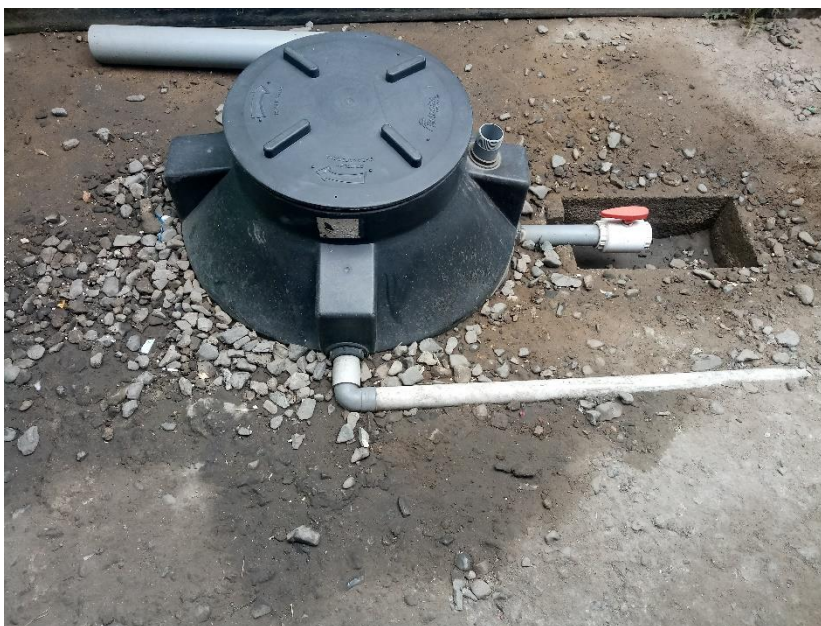
Fotografía 10. Vista de un biodigestor instalado y su caja de lodos semiconstruida
