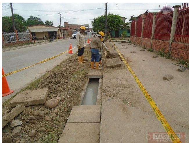
Figura 5. Sistema Alcantarillado Pluvial
