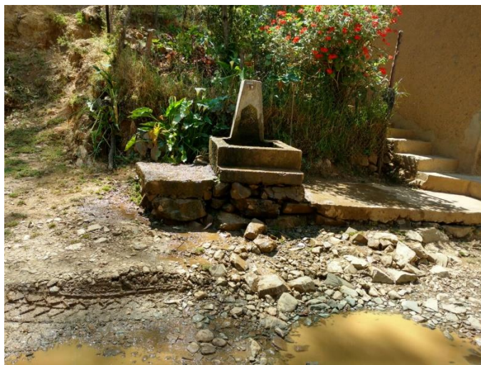
Fotografía 2. Vista de una piqueta en una vivienda del caserío de Huayabas.
