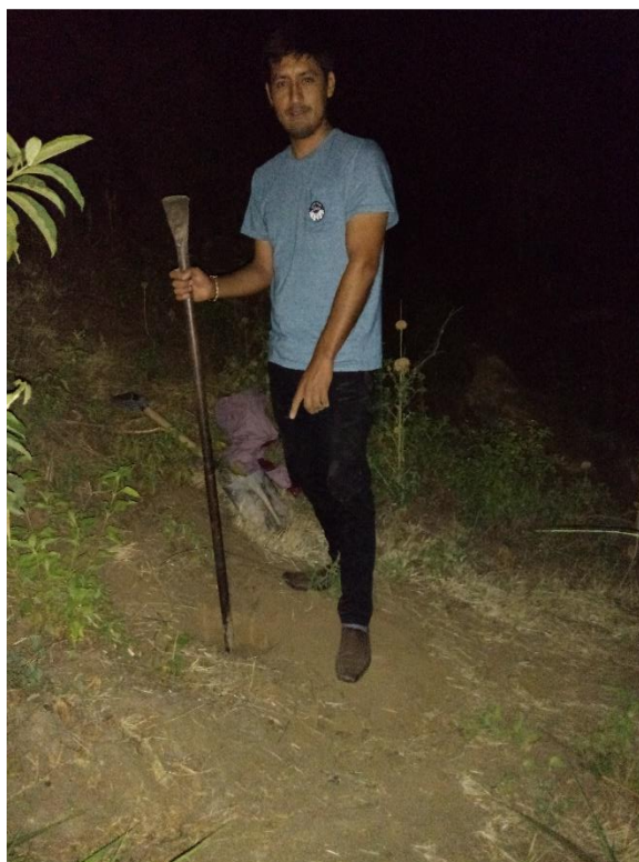
Fotografía 11. Excavación de calicata para test de percolación In Situ
