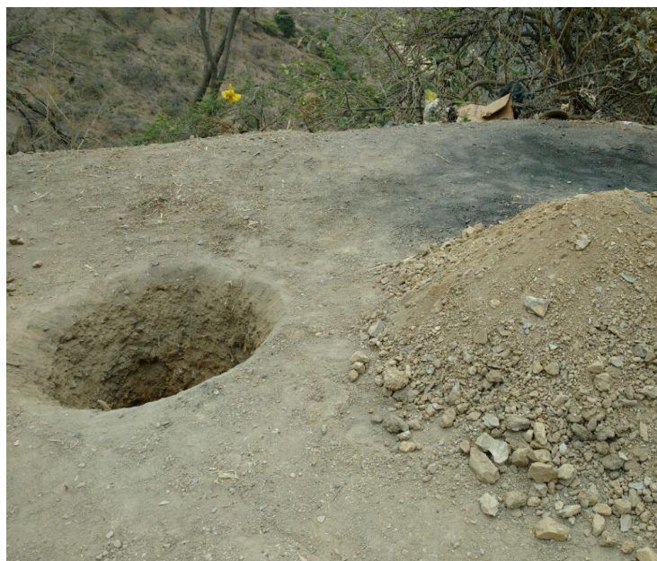
Fotografía 13. Excavación de calicata para estudio de suelo.
