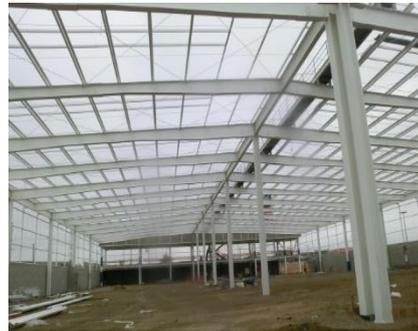
*Figura 3.12* Montaje de Estructuras metálicas.
