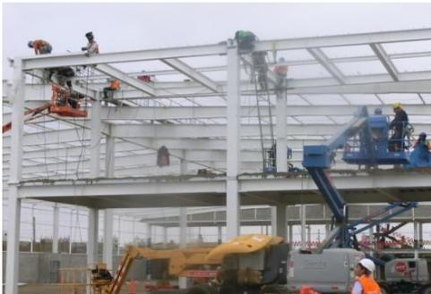
*Figura 3.11* Proceso de montaje Tienda Promart -Chimbote
