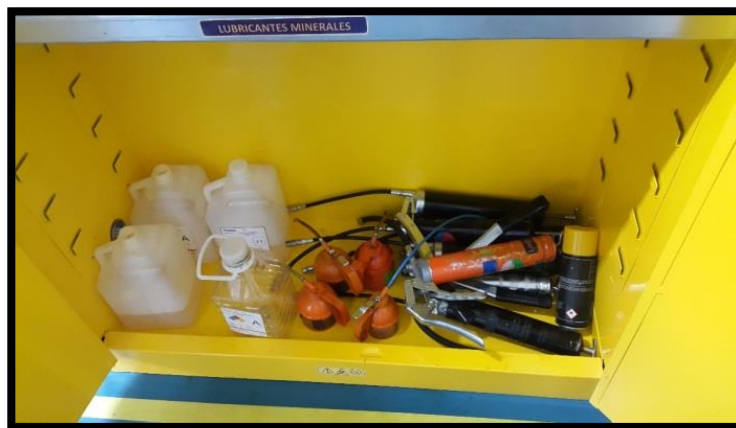
Figura n°. 1-6 Falta de 5's en los locker
