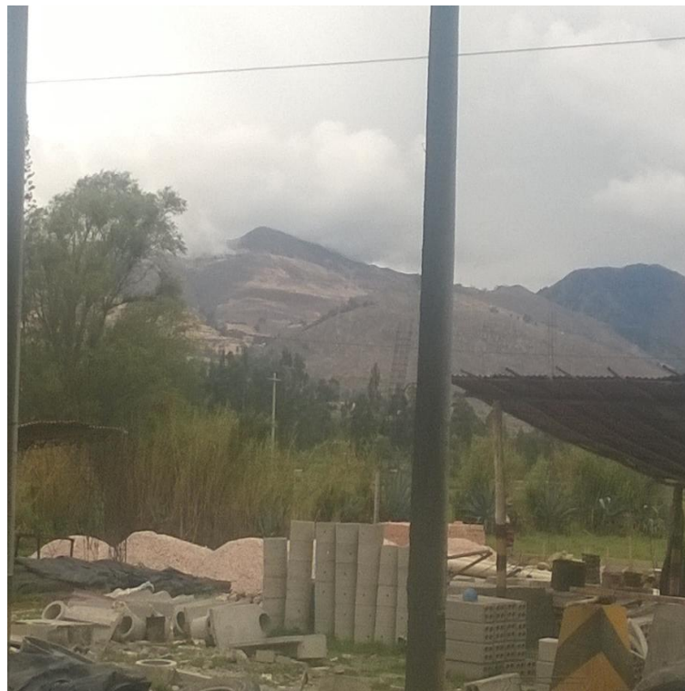
Figura 26 Área de recepción de materiales
