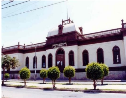
Imagen n° 5.75. La Antigua Estación Del Ferrocarril (N° 2900 – 72)
