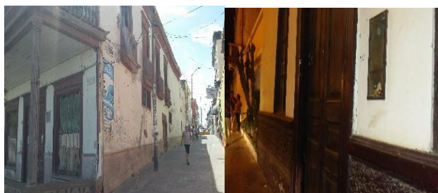
Imagen n° 1.6. Estado de conservación de las edificaciones
