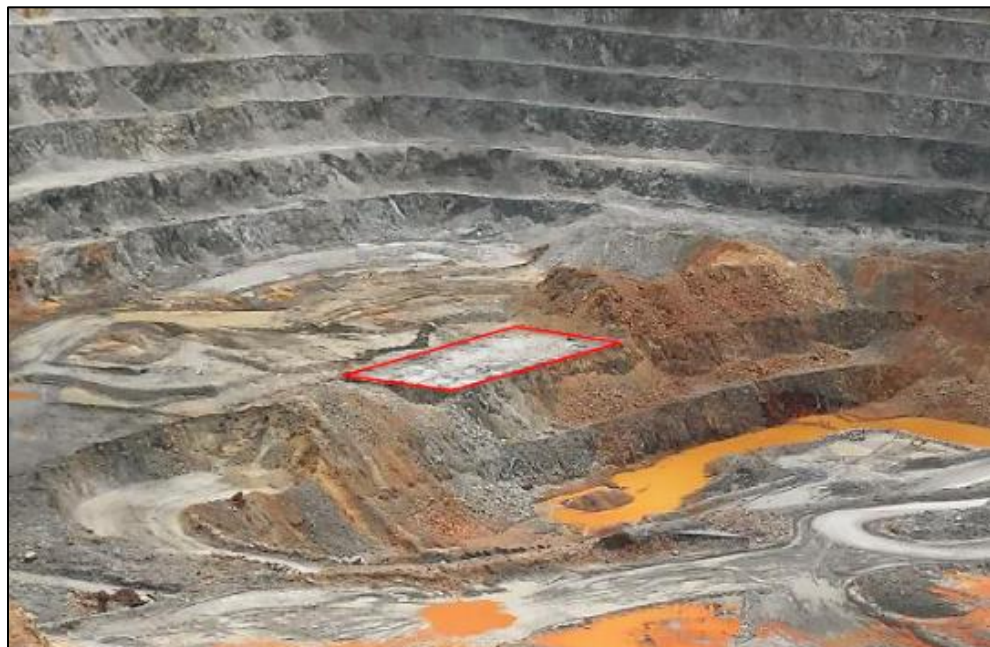
Figura 66: Imagen pre voladura P 3710-025. Fuente: Oficina de asistencia técnica EXSA – Cerro Corona, 2017.
