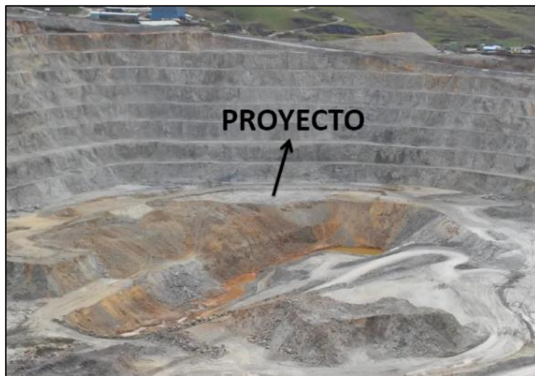
Figura 86: Imagen pre voladura P 3710-032. Fuente: Oficina de asistencia técnica EXSA – Cerro Corona, 2017.
