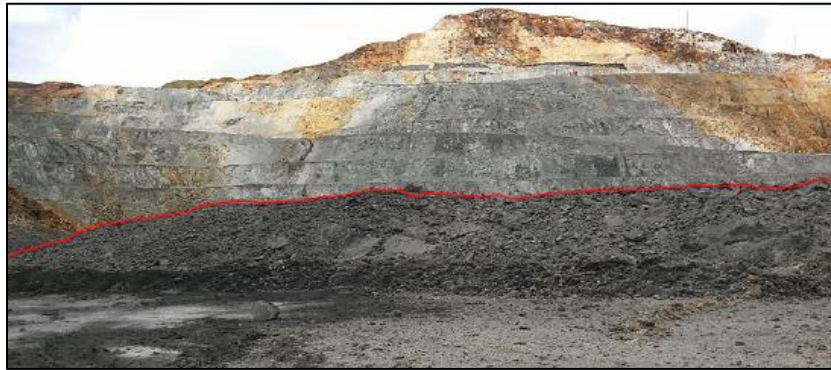
Figura 67: Imagen post voladura P 3710-025.
