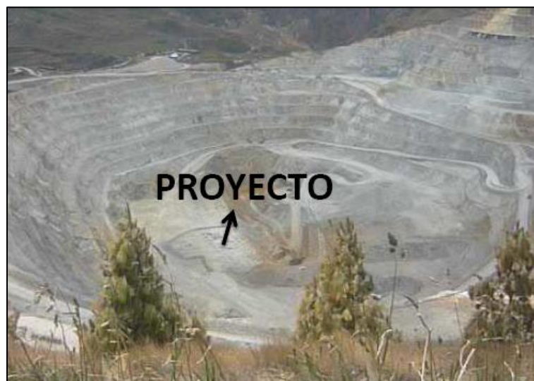
Figura 107: Imagen pre voladura P 3700-010. Fuente: Oficina de asistencia técnica EXSA – Cerro Corona, 2017.
