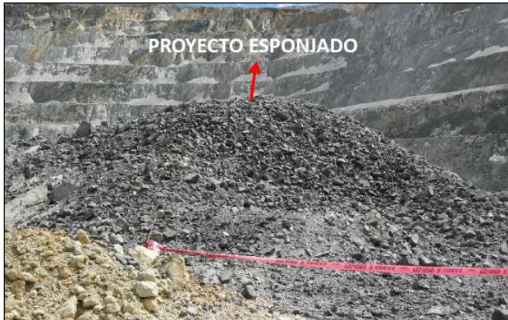
Figura 94: Imagen post voladura P 3710-035.
