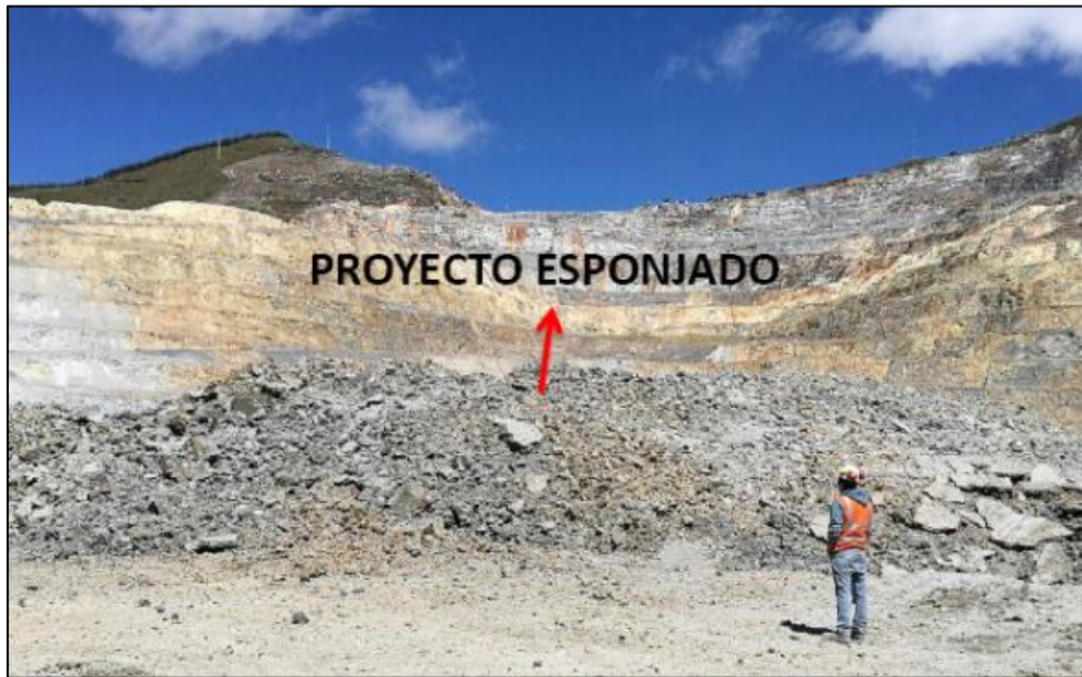
Figura 74: Imagen post voladura P 3710-027.
