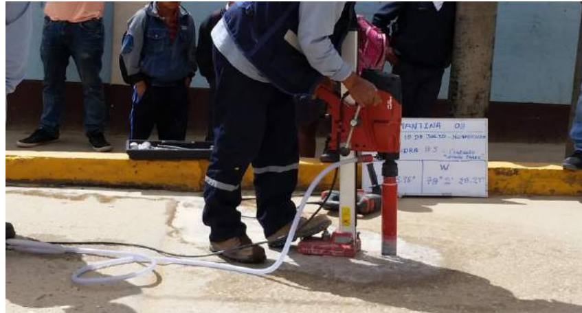
Figura N° 3. Perforación y extracción de núcleos.
