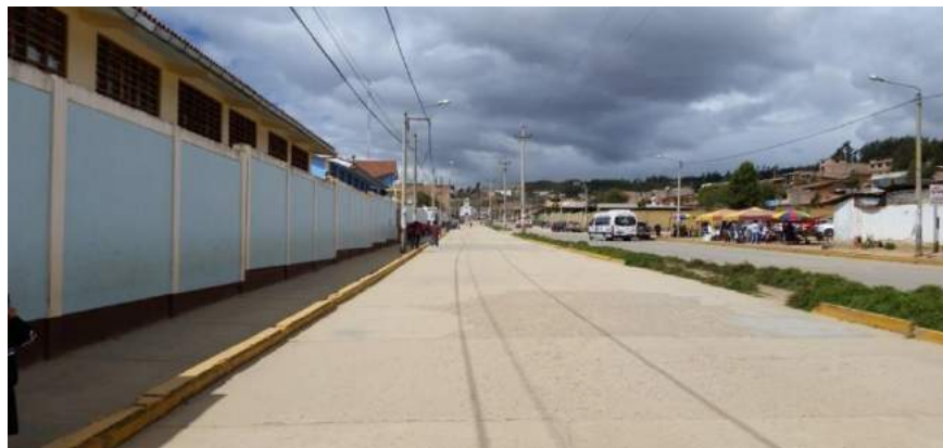
Figura N° 1 Estado actual de la Av. 10 de Julio
