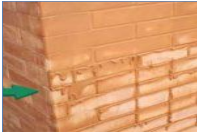
Figura n.º 39 Impermeabilización de muros
