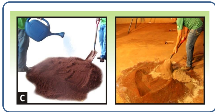
Figura n.º 15 Agregando agua a la mezcla
