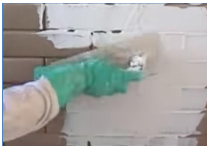
Figura n.º 40 Enlucidos de muros con yeso
