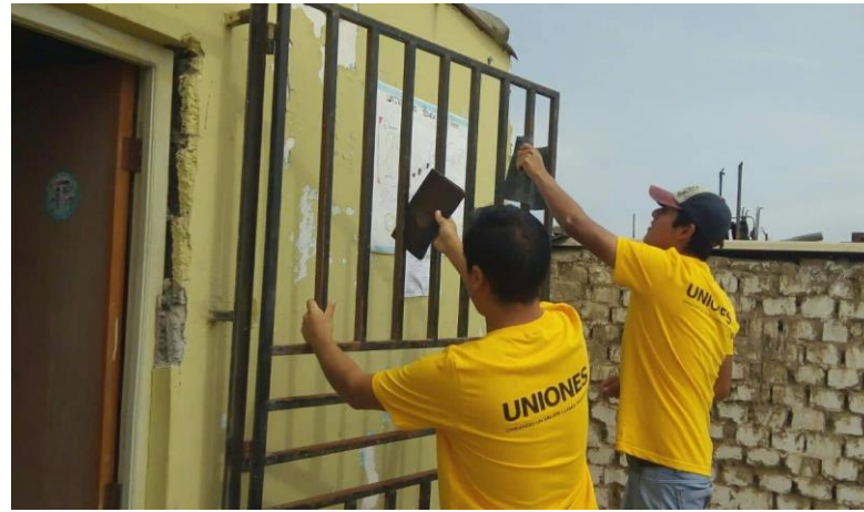
Figura 1: Lijado de puerta
