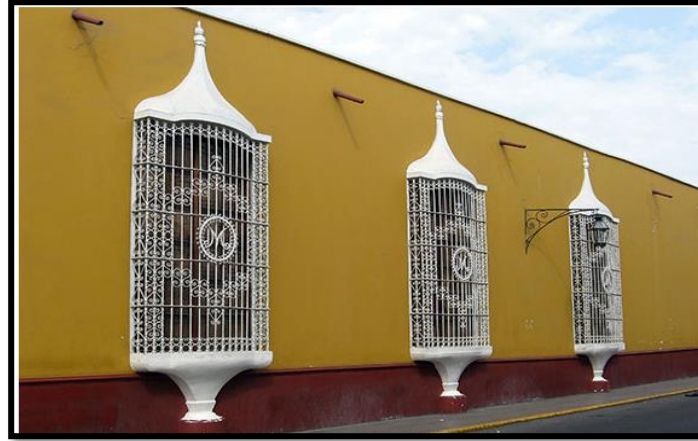
Figura 6: Eflorescencias en la casa de la emancipación (Arias, 2004)
