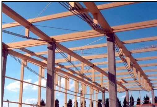
Figura N° 3: Postes y vigas de madera. (Guillermo, 2018)
