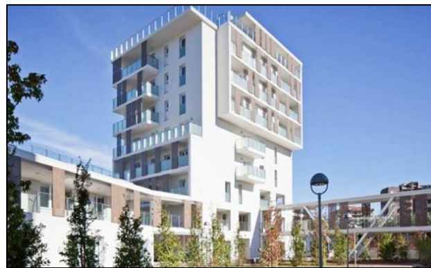
Figura N° 40: Milano Vía Cenni (2014).
