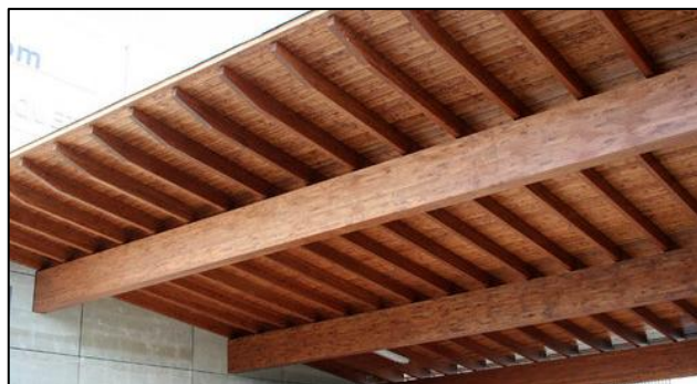
Figura N° 4: Cubiertas de madera. (Guillermo, 2018)
