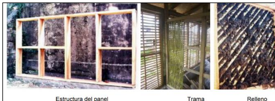
Figura N° 5: Estructura de panel de madera con tierra. (Schiller, S. y Evans, J. 2006)
