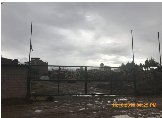
Figura 3.2: Fachada de la cantera Roca Fuerte
