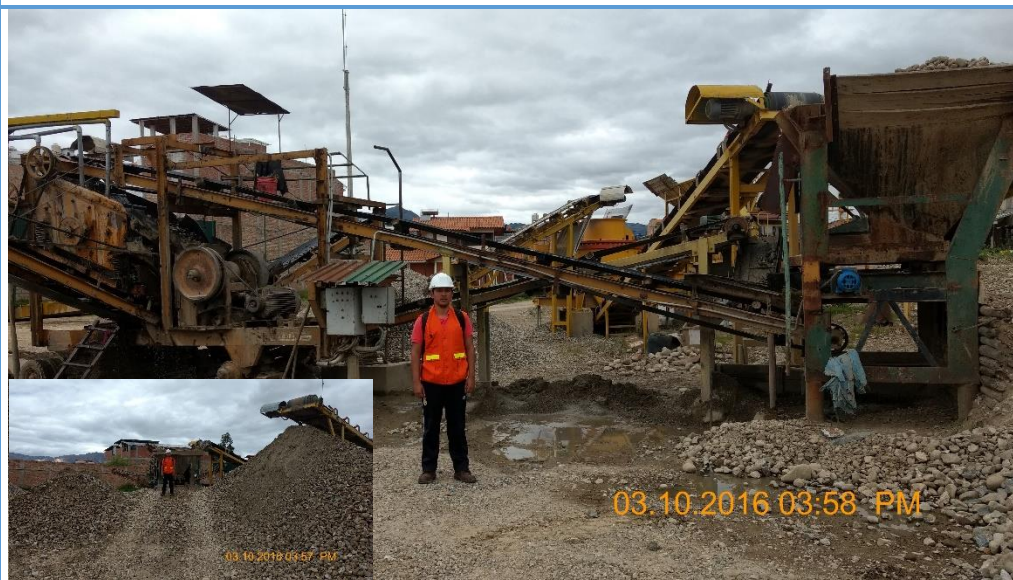
Figura 3.8: Triturado del concreto reciclado en la chancadora de cono (secundaria).
