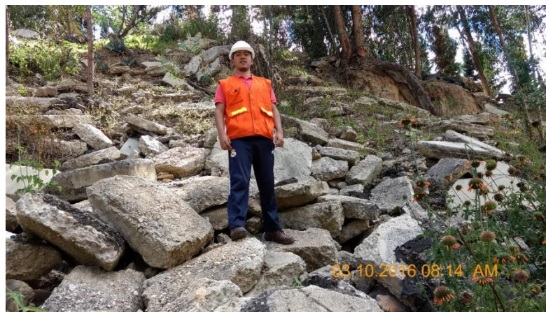
Figura 3.4: Reconocimiento del botadero.
