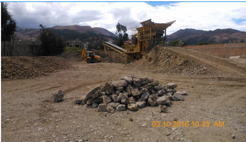
Figura 3.6: Se llevó el concreto reciclado del botadero hacia la chancadora en un volquete de 6 m 3 , en el cual se cargó aproximadamente 4 m 3 .
