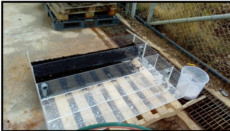
Figura N° 12. Adaptación del humedal a la zona
