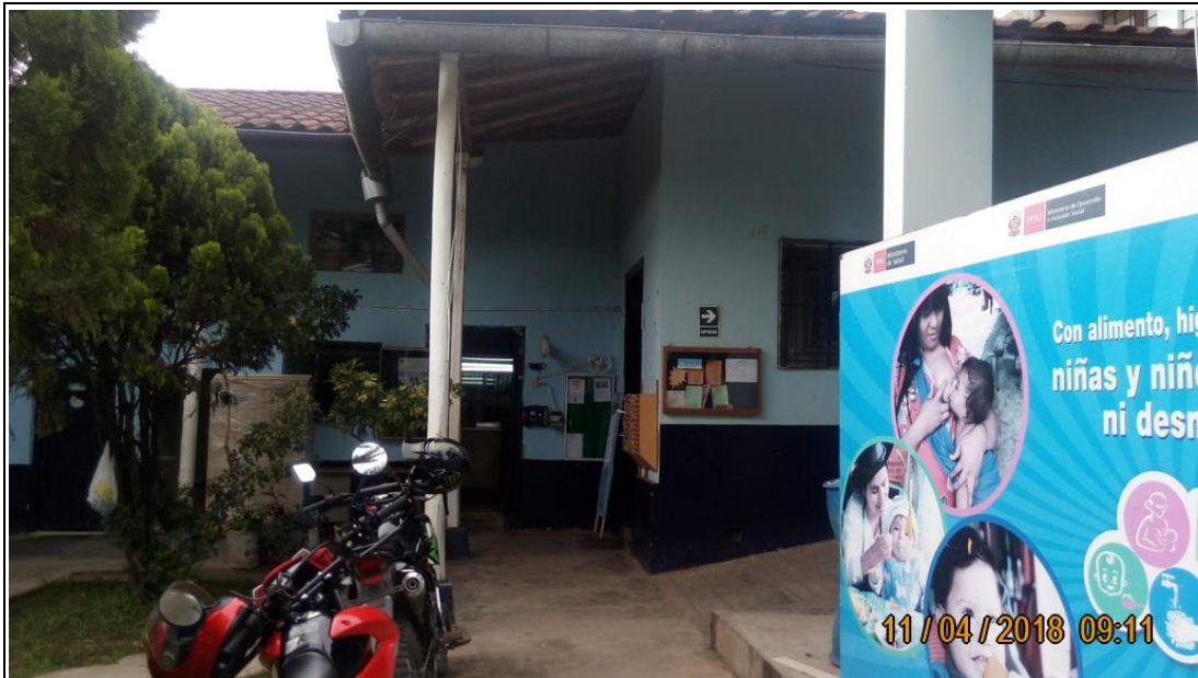
Foto N° 3: Rutas de evacuación
