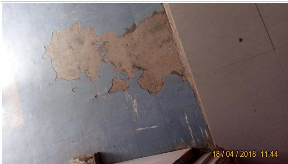
Foto N° 26: Pisos deteriorados
