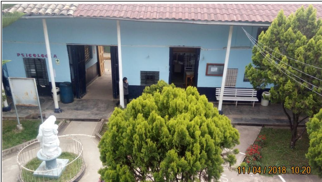
Foto N° 2: Vista estructuras de adobe
