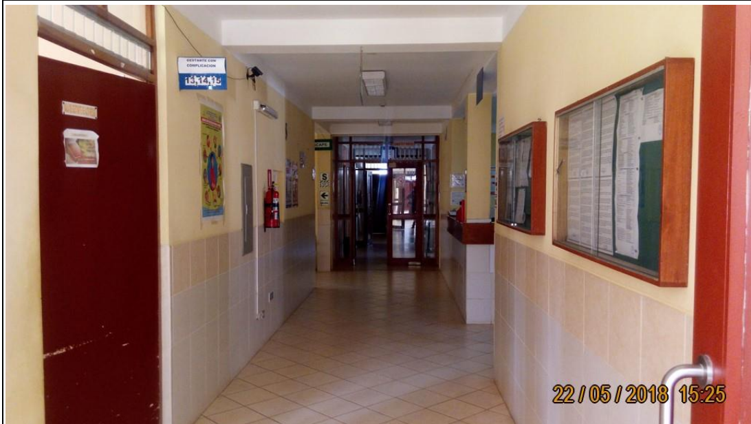
Foto N° 39: Pasadizos y rutas de evacuación
