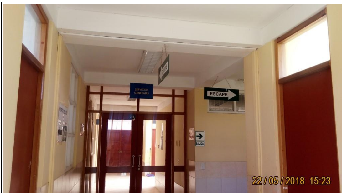
Foto N° 38: Rutas de evacuación
