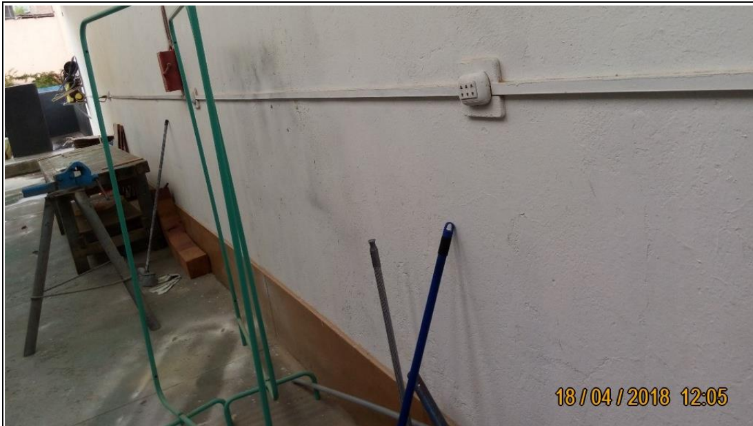
Foto N° 25: Rutas de evacuación
