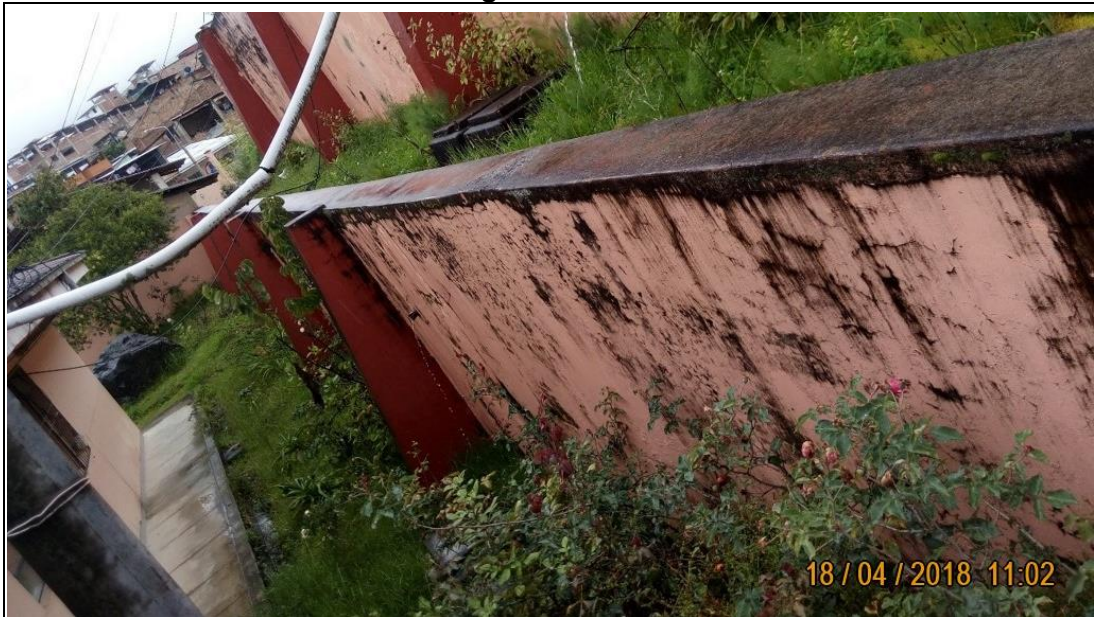
Foto N° 19: Vista general muro de contención
