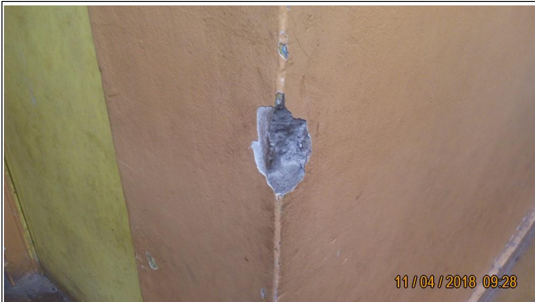
Foto N° 7: Columnas deteriorados
