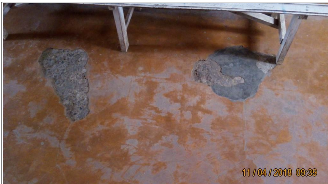
Foto N° 8: Pisos deteriorados
