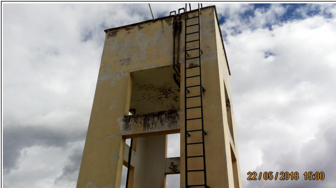
Foto N° 34: Escalera reservorio elevado
