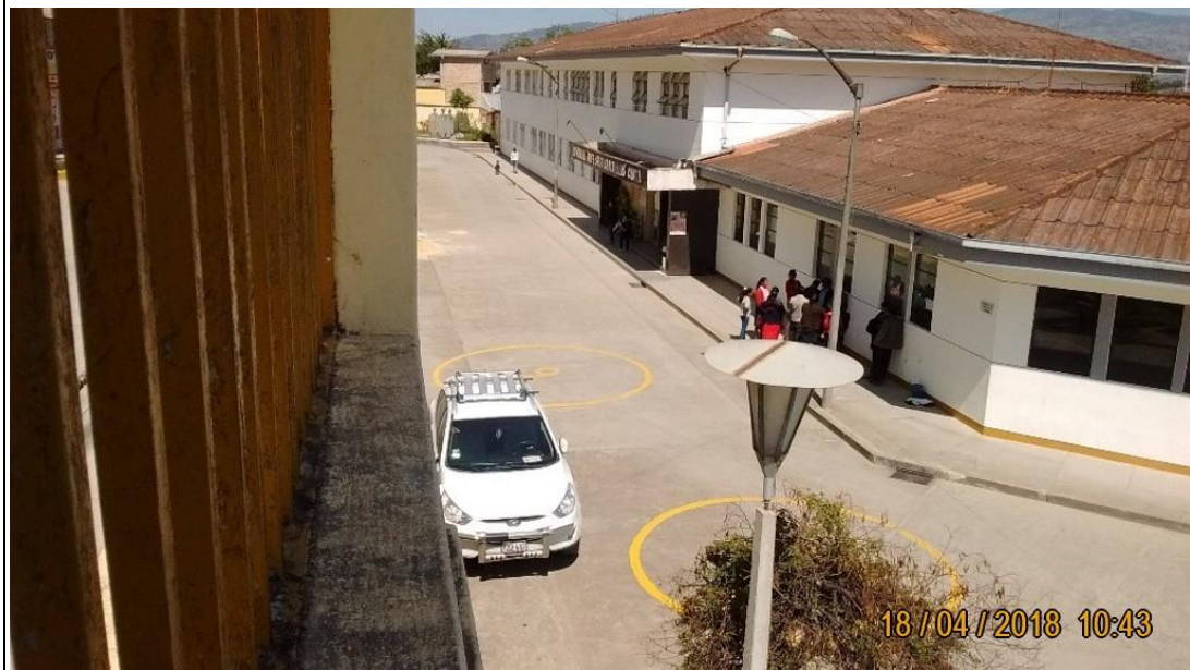
Foto N° 17: Vista de ingreso principal del Hospital José Soto Cadenillas
