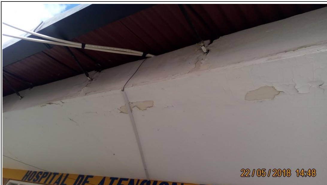
Foto N° 30: Cielorraso deteriorado
