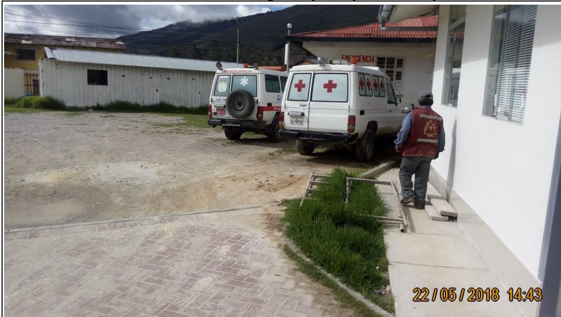
Foto N° 29: Vista de ingreso principal del Hospital
