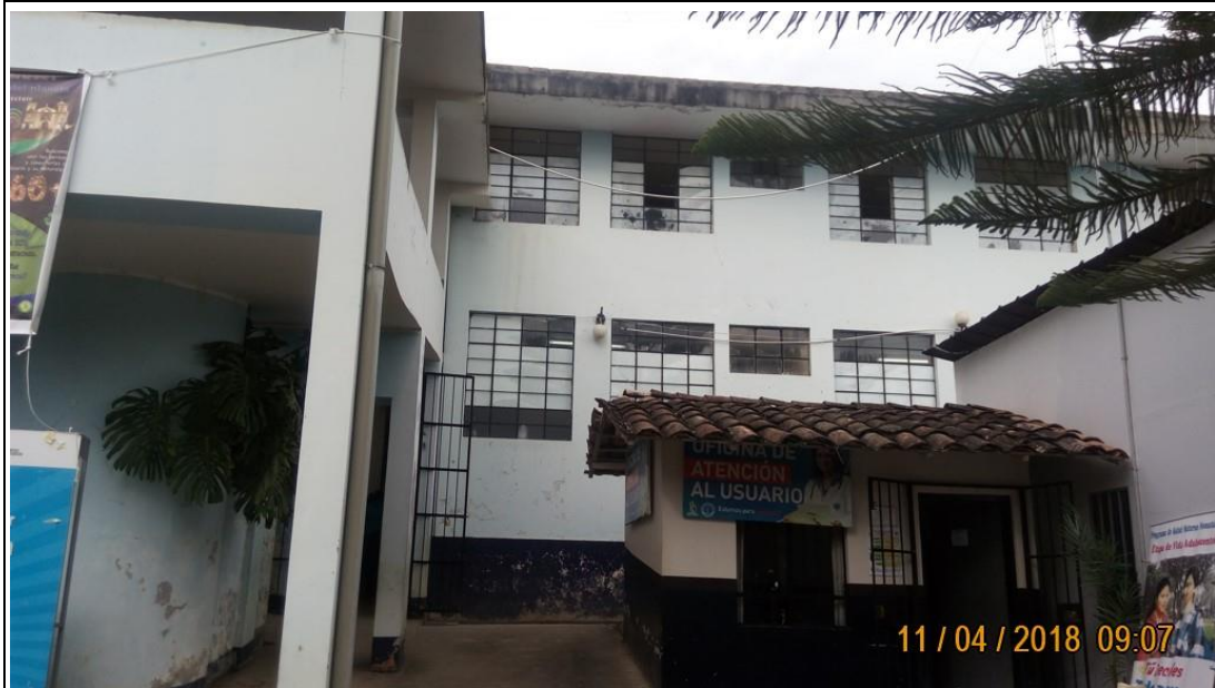
Foto N° 1: Vista de estructuras de concreto armado
