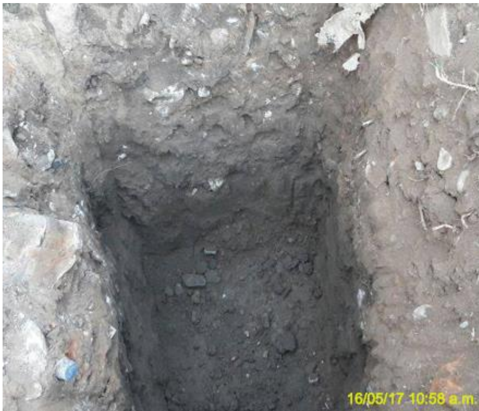
Fotografía N°2: Dimensiones de la calicata 1.00x1.00x1.80
