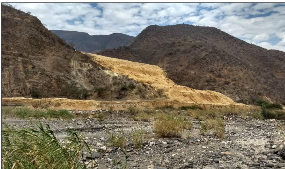
Ilustración 23- Talud del relave minero Paredones, el cual se encuentra prácticamente a orillas del río San Pablo. Fuente: Elaboración propia.
