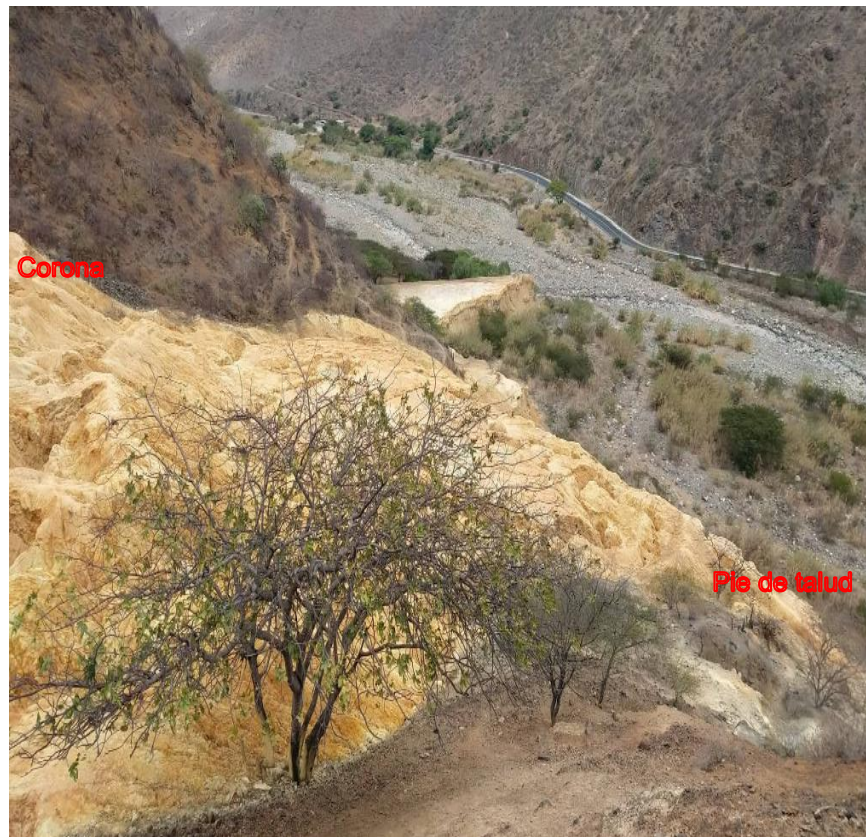
Ilustración 34- Material expuesto desértico, se evidencia desde la corona hasta el pie de talud.
